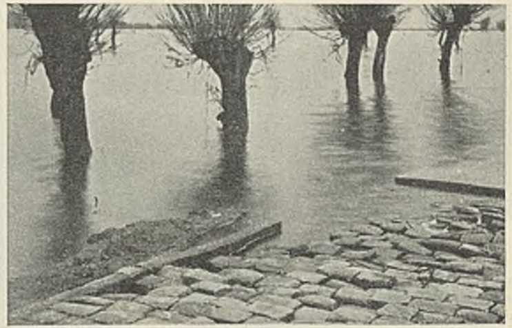
Abb. 19. Reihenpflaster nach dem Hochwasser.
