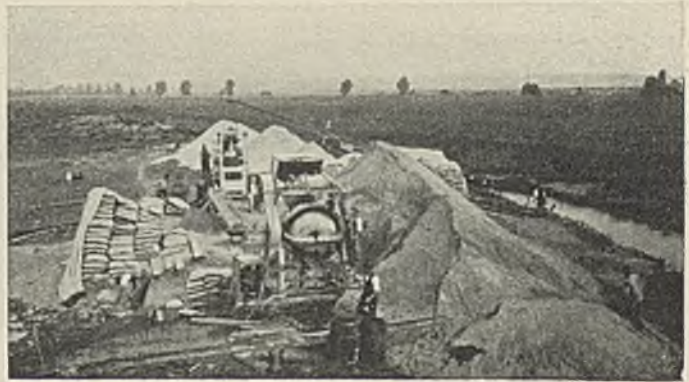
Abb. 13. Lagerplatz und Mischmaschine.
