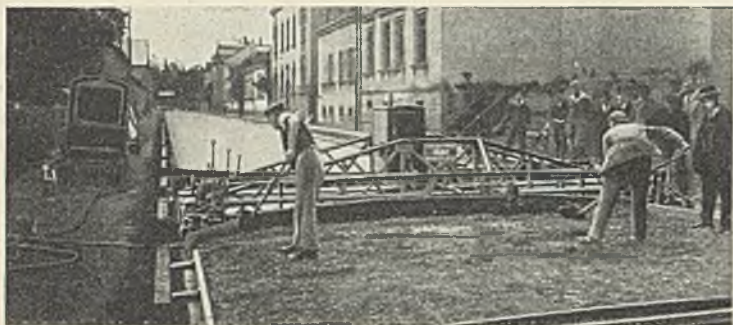
Abb. 9. Straßenfertiger „Dingler“ bei Herstellung einer Betonstraße.
