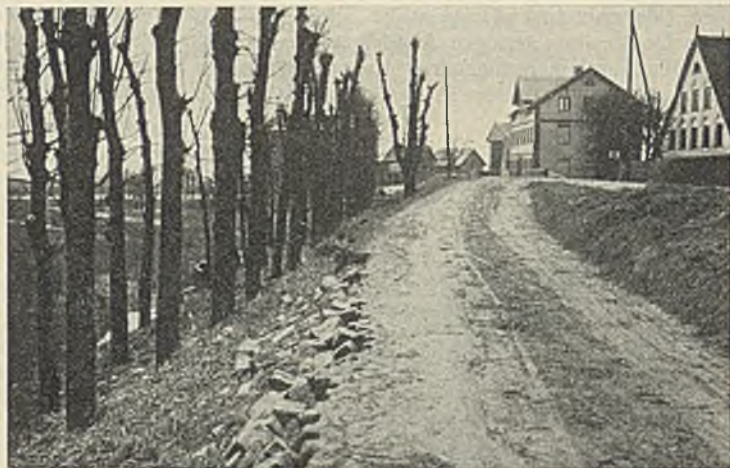
Abb. 17. Rampe in Altenwerder nach dem Hochwasser.
