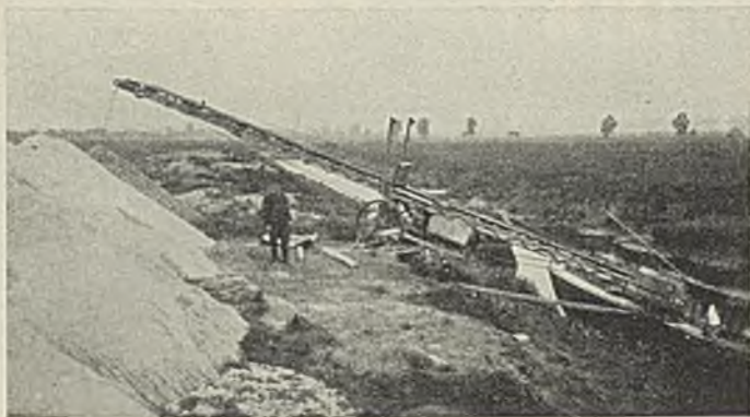
Abb. 12. Löschen der Baustoffe.
