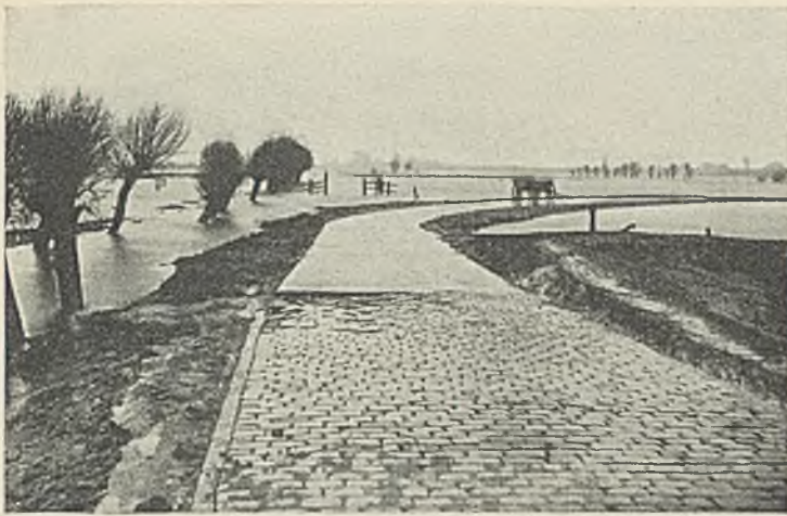
Abb. 18. Reihenpflaster nach dem Hochwasser.
