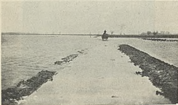
Abb. 20. Straße Altenwerder—Finkenwerder unter Hochwasser.
