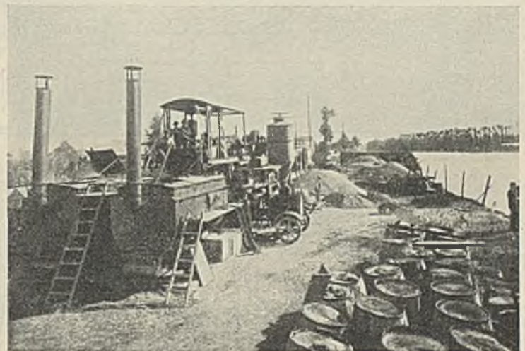
Abb. 16. Straßenbaumaschine für 12 t Stundenleistung auf der Baustelle.
