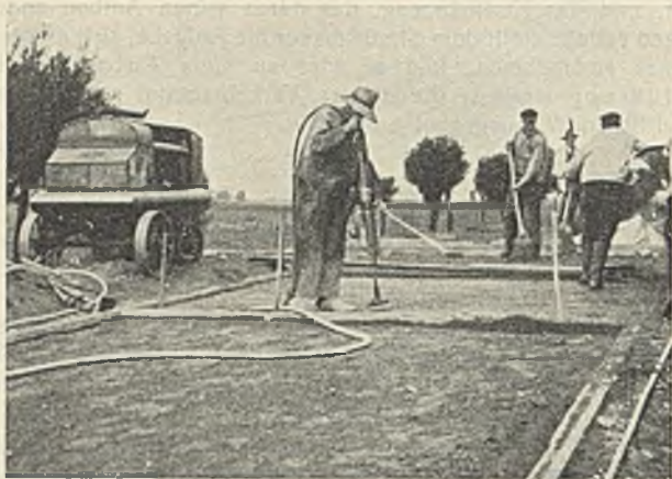
Abb. 14. Einbringen und Stampfen des Betons.
