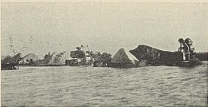
Abb. 16. Baustelle unter Hochwasser am 21. September 1929.
