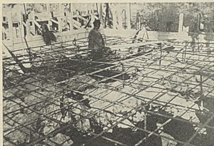
Abb. 18. Bewehrung der Eisenbetonplatte des Sturzbeckens.
