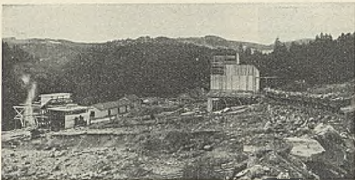
Abb. 9. Aufbereitungsanlage für die Schluchseesperre (23. X. 29).
