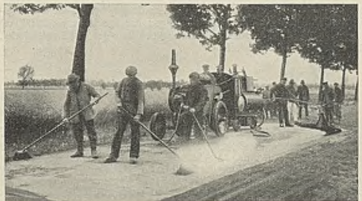
Abb. 27. Knorr-Druckluft-Straßenbaumaschine bei der Arbeit.
