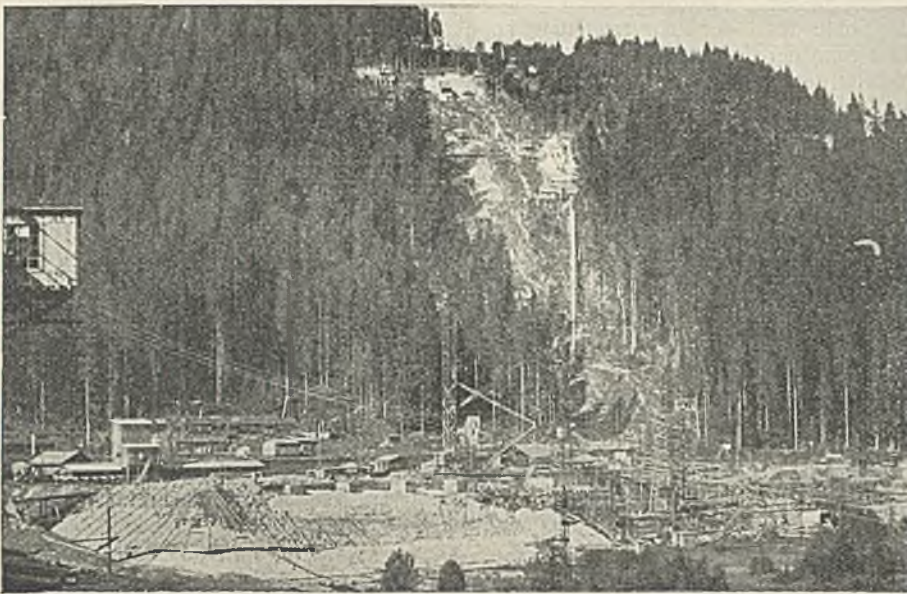
Abb. 11. Baustelle des Kraftwerks Häusern bei Schwarzabruck (22. X. 29).
