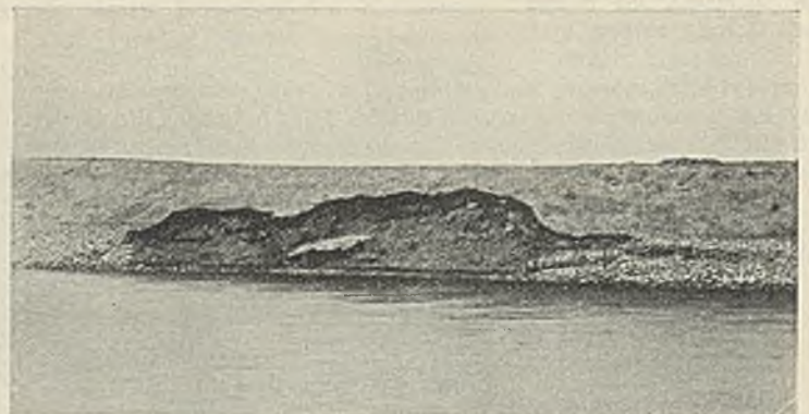
Abb. 11. Rutschung auf der Südwestseite des Dükers.
