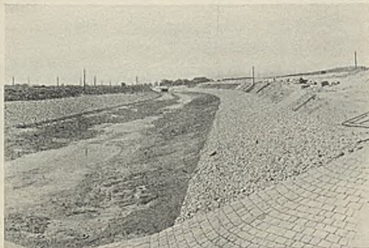
Abb. 2. Fertige Uferbefestigung.
