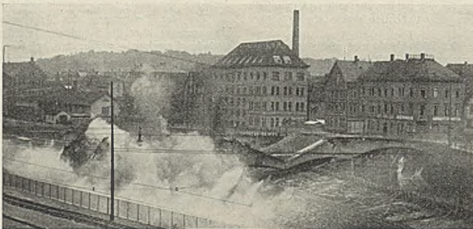
Abb. 7. Brücke während der Sprengung. Ansicht vom Oberwasser aus.
