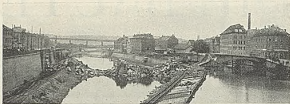
Abb. 8. Brücke nach der Sprengung.
