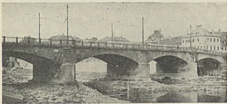
Abb. 2. Ansicht der Wilhelmsbrücke vor der Sprengung.
