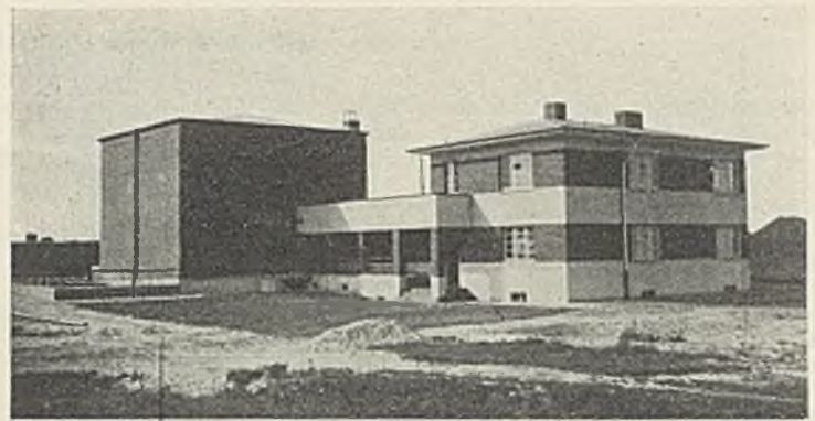
Abb. 15. Ansicht des Pumpwerks Essen-Karnap von Norden.
