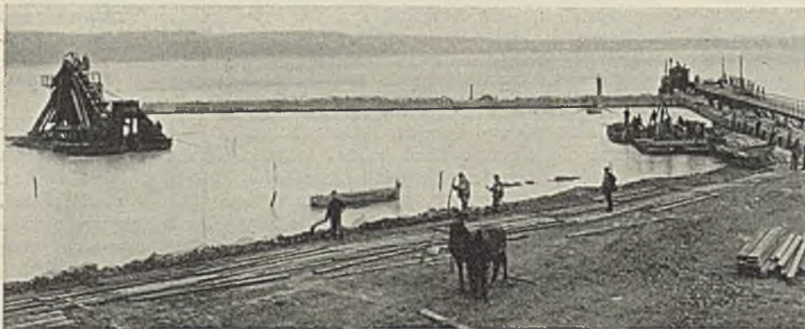
Abb. 4. Hafenanlage Konstanz-Staad. Baustellenübersicht März 1927.
