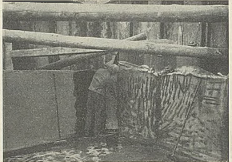
Abb. 3. Aufbringen der Isolierung. Links Zementputz, in der Mitte Anstrich, rechts die einzelnen Dichtungsbahnen.
