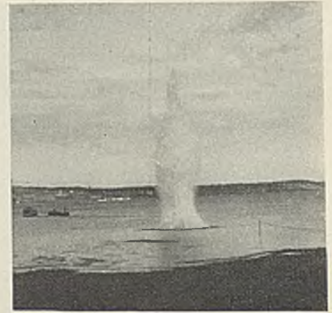
Abb. 5b. Sprengschuß in der Zufahrttrinne.
