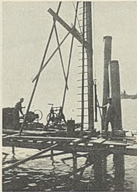
Abb. 10a. Bohren der Pfahlöcher für die Leitwerkdalben.
