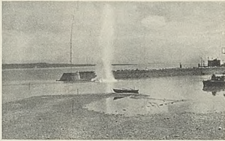
Abb. 5a. Sprengschuß in der Zufahrttrinne mit Hafenmauer bei Niederwasser.
