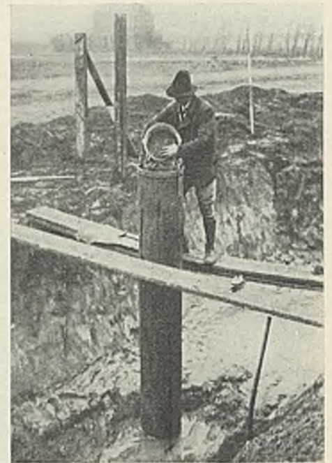
Abb. 13. Sicherheitspumpensumpf vor dem Ein-spülen, der Filterkies wird eingefüllt.
