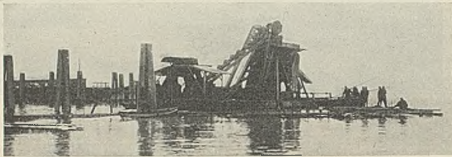
Abb. 11. Herstellung der Sprenglöcher und Ausbaggerung des Sprenggutes.
