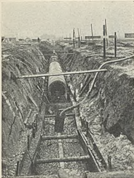
Abb. 14. Kanalbaugrube mit Sicherheitspumpensumpf und in Kies verlegter Dränage.
