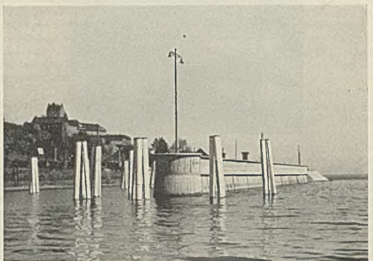
Abb. 19. Ansicht der Eisenbetonmole mit Molenkopf.
