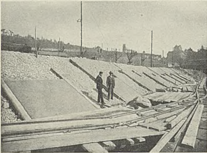
Abb. 26. Betonieren der Uferböschung.
