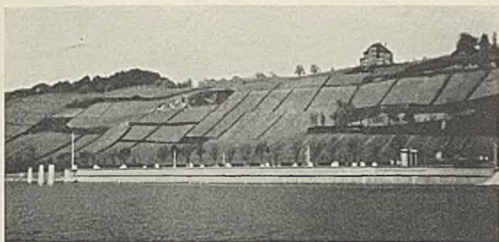
Abb. 18. Außenansicht der Eisenbetonmole.
