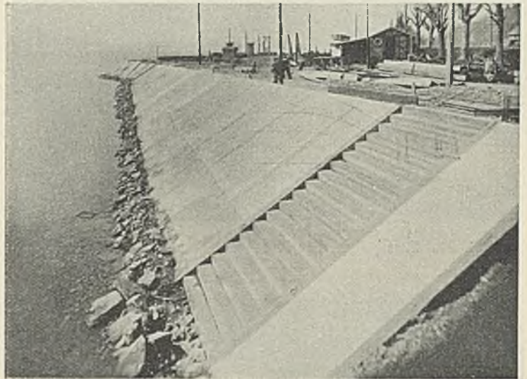
Abb. 27. Die fertig betonierte-Uferböschung.
