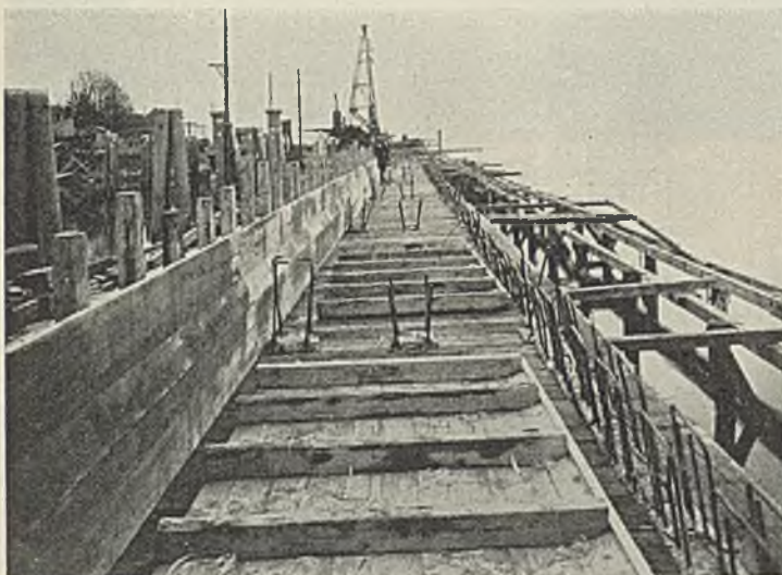
Abb. 22. Herstellung der Schalung für die Eisenbetonplatte der Mole.
