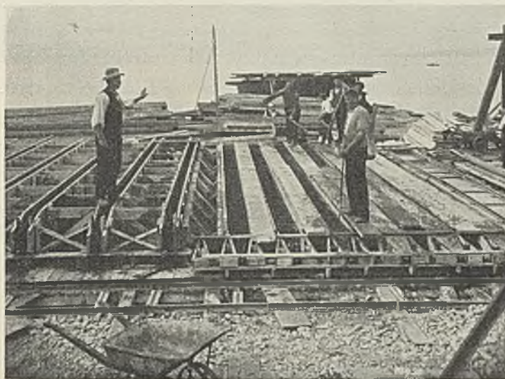
Abb. 21. Herstellung der Pfähle und Spundbohlen für die Eisenbetonmole.
