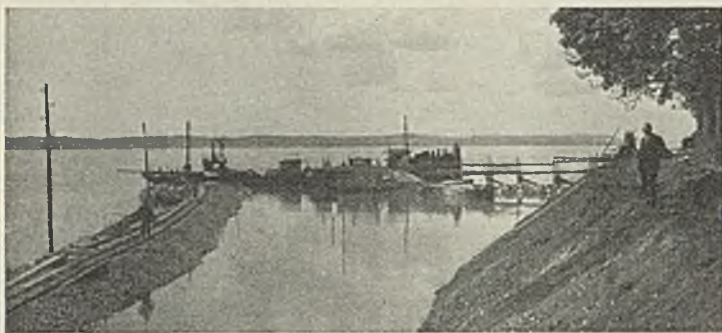
Abb. 28. Auffüllung des Verkehrsplatzes (11. Mai 1928).
