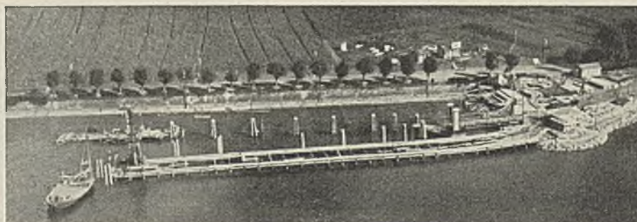
Abb. 24. Blick auf die Baustelle (Fliegeraufnahme).
