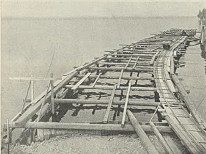
Abb. 13. Rammgerüst für die Eisenbetonmole.
