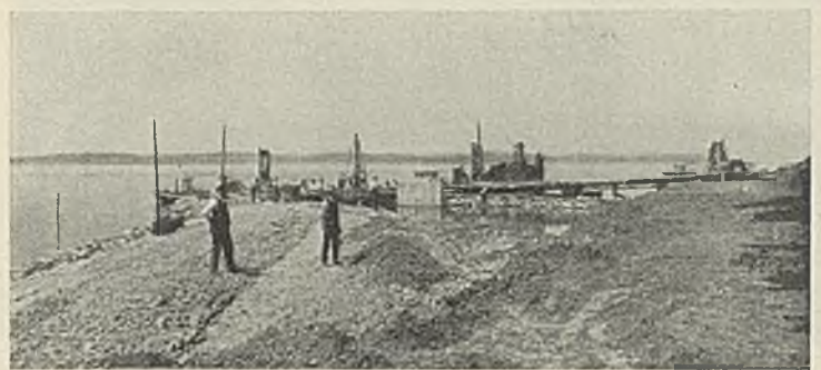
Abb. 29. Auffüllung des Verkehrsplatzes (Ende Mai 1928).
