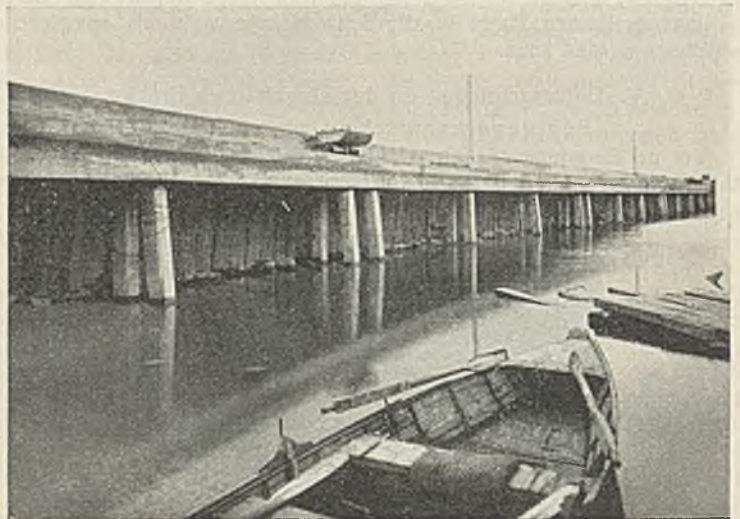
Abb. 17. Innenansicht der Eisenbetonmole.
