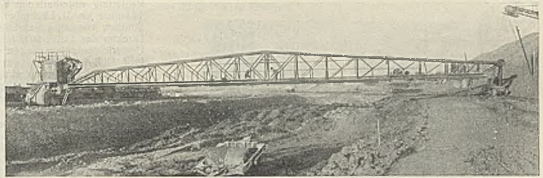
Absetzer beim Einbringen einer Tonschicht.
