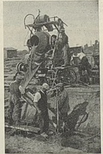
Abb. 23. Pfeilerfundierung der Flutbrücke. Füllung der Pfahlhülsen mit Beton.
