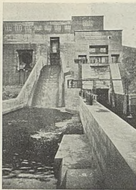
Abb. 8. Unterhaupt und Leerschluß.
