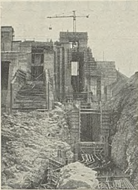
Abb. 2. Schleusenanlage während des Baues, im Vordergrund Ablaufkanal nach dem Leerschuß.
