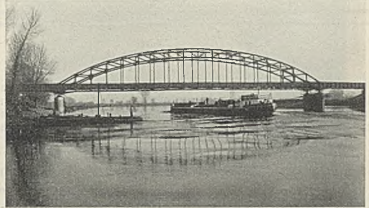
Abb. 32. Ansicht der Strombrücke (Unterstromseite).
