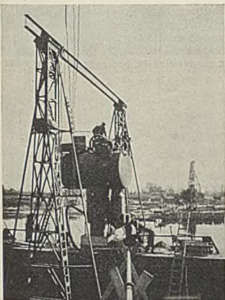
Abb. 21. Absenkung des rechten Strompfeilers II und Insel für den linken Strompfeiler III.
