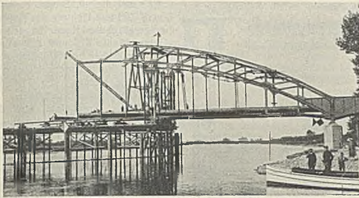
Abb. 30. Aufstellung des Überbaues für die Strombrücke nach Abstützung des freimontierten Bogenteils über der Schiffsdurchfahrt.
