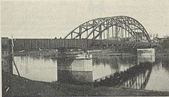
Abb. 31. Ansicht der Strombrücke (Oberstromseite).
