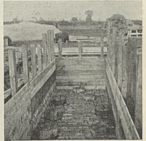
Abb. 24. Pfeilerfundierung der Flutbrücke; Pfahlköpfe und Isolierflachschicht.
