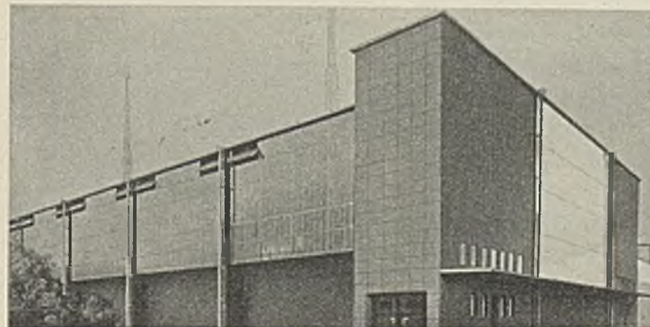
Abb. 9. Außenansicht der fertigen Halle. Kopfbau mit Vordach und seitlicher Einfahrt in den Entladebahnhof im Erdgeschoß.
