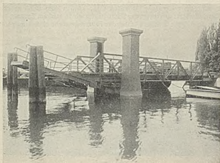
Abb. 38. Die fertige Landebrücke in Konstanz-Staad.
