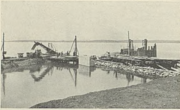
Abb. 40. Hafenanlage Meersburg. Aufstellen der Hebewerkständer im Schutz der Larssenwand. In der Mitte das fertige Brückenwiderlager. Links das Förderband zur Förderung des Baggerguts.
