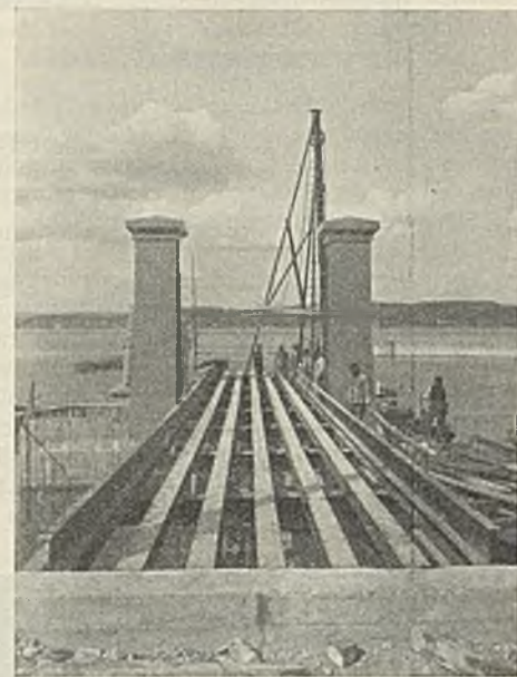
Abb. 35. Landebrücke in Konstanz-Staad. Montage der Quer- und Längsträger mit den als Pylonen ausgebildeten Hebewerkständern.
