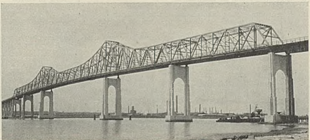
Abb. 39. Brücke über den Arthur Kill zwischen New Jersey und Staten Island (New York) im fertigen Zustande.
