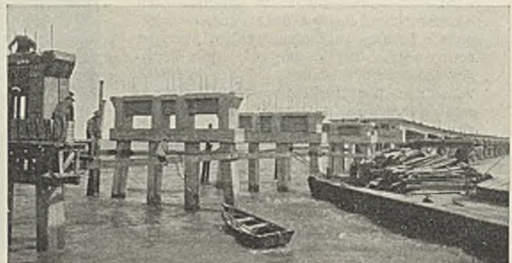
Abb. 30. Die San Francisco Bay Toll Bridge im Bau.
