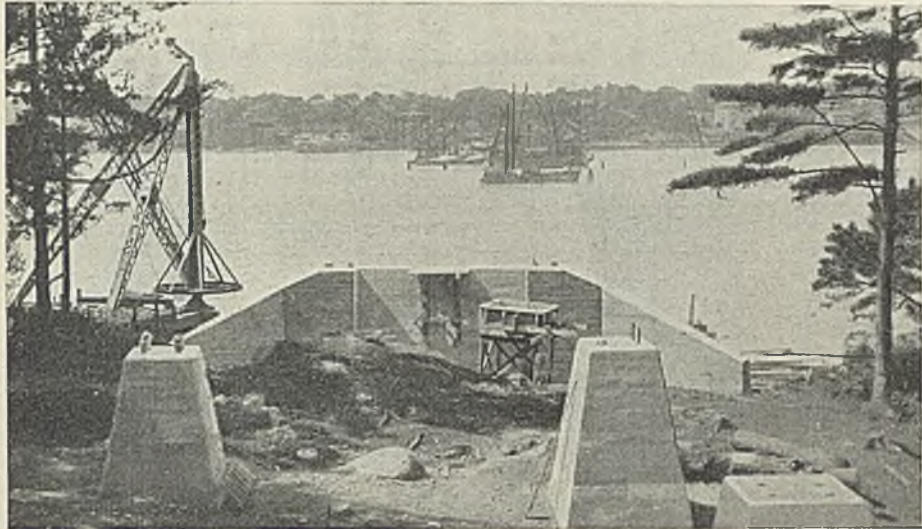
Abb. 22. Ein Widerlager (fertig gestellt).
