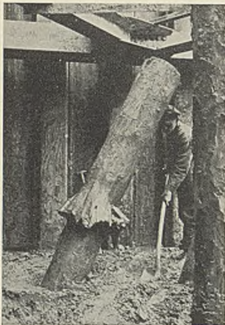
Abb. 14. Schwach gestauchter Pfahl.
