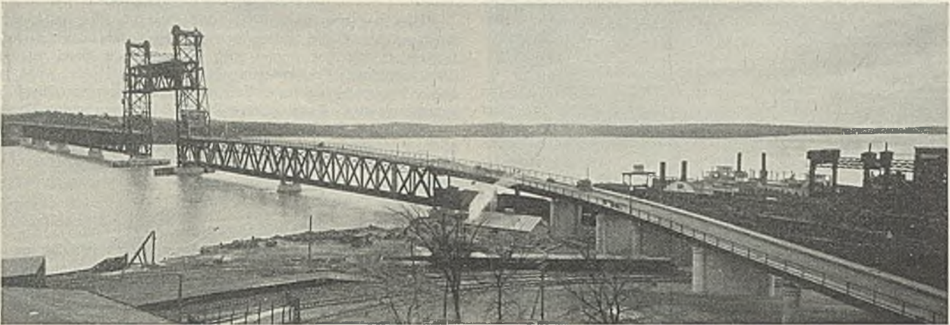
Abb. 9. Brücke über den Kennebec River in Bath (Maine) mit Fahrbahn oben für Straßenverkehr und Fahrbahn unten für die Maine Central Railroad. Die Endöffnungen besitzen 83 m, die Öffnungen zur Seite der Hubbrücke 100 m Lichtweite. Stützweite der Hubbrücke 73 m, Lichtweite 61 m, Lichthöhe 41,2 m. Zu hebende Gesamtlast 1260 t an 64 Kabeln von je 5,4 cm Durchm.
