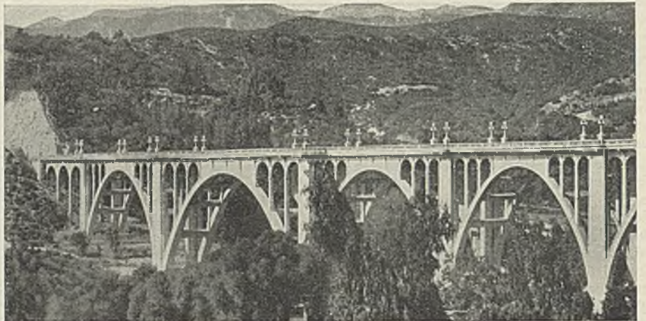
Abb. 34. Brücke über den Arroyo Seco in Pasadena (California). Brücke für Straßenverkehr. Straßenbreite 12 m mit zwei Fußsteigen von 1,50 m Breite. Eine Bogenweite ist 68 m, zwei je 46,5 m, sechs je 34,5 m, Länge zusammen 450 m.
