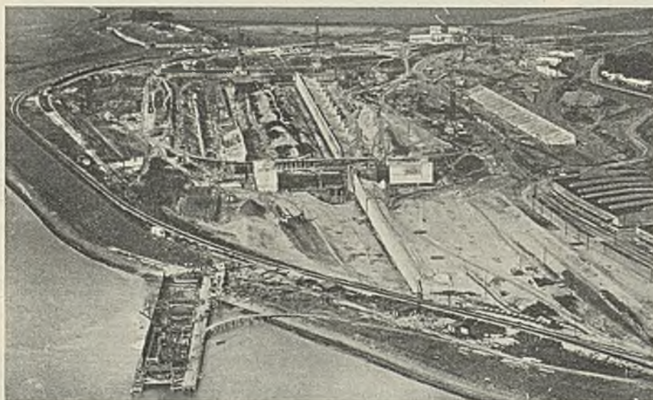
Abb. 45. Flugzeugaufnahme der Bauarbeiten im September 1929.
