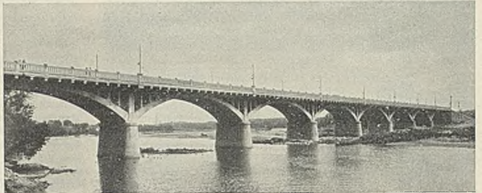
Abb. 33. Eisenbeton-Bogenbrücke über den Colorado River in Austin, Texas. Acht Öffnungen zu 36,6 m. Die Straßenbreite beträgt 11,3 m. Beidseits Fußgängerstege von je 1,5 m.
