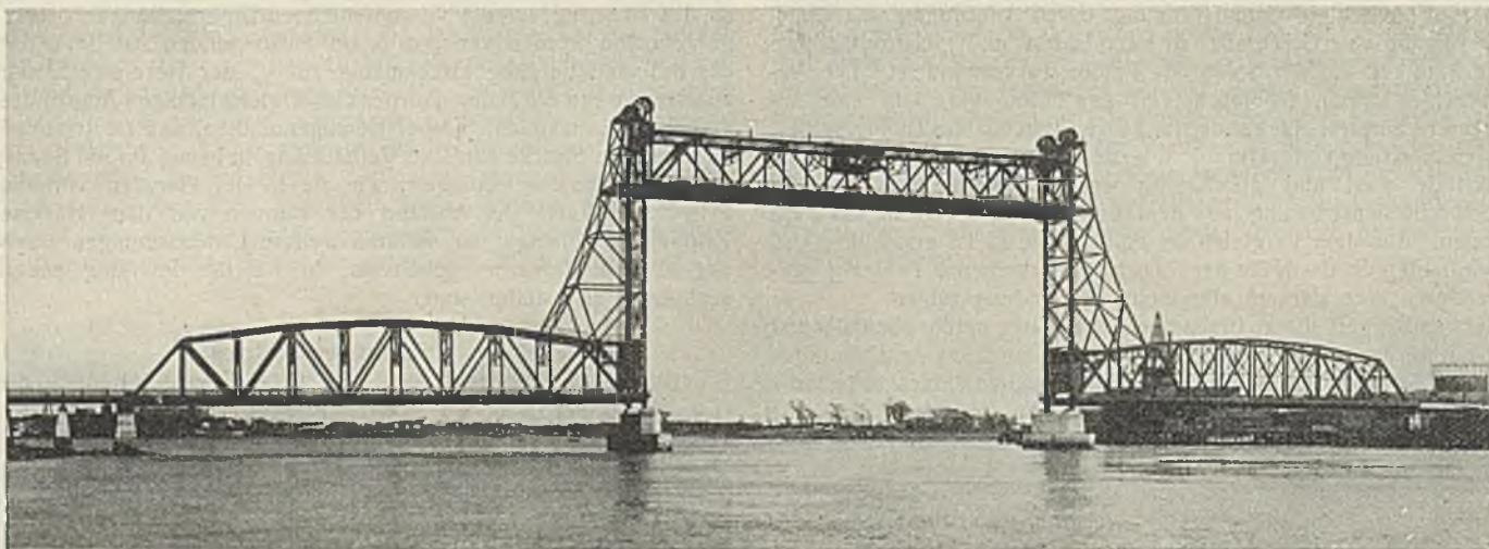
Abb. 3. Hubbrücke über den Piscataqua-Fluß in Portsmouth, New Hampshire. 3 Spannweiten von 91,5 m. Die lichte Höhe der für die Schifffahrt geöffneten Brücke beträgt 45,75 m.
