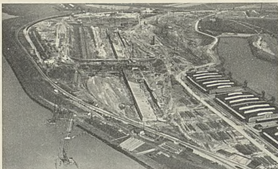
Abb. 44. Flugzeugaufnahme der Bauarbeiten im Juni 1929.
