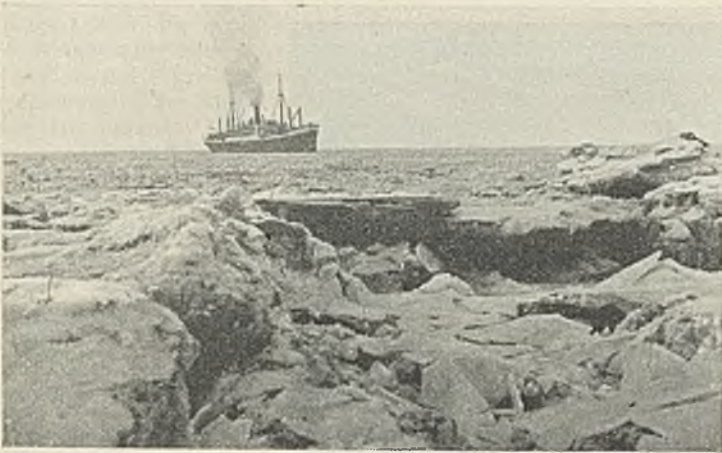
Abb. 47. Molenbaustelle bei Eisgang, Winter 1928/29.
