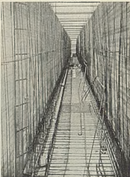
Abb. 14. Bewehrung der Tauchwand.
