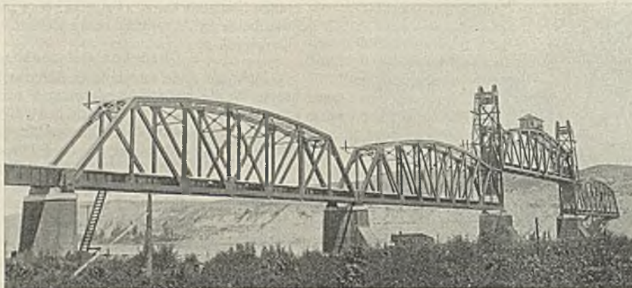
Abb. 46. Brücke der Great Northern Railway über den Yellowstone River (Montana). Die Spannweiten betragen 84 m.
