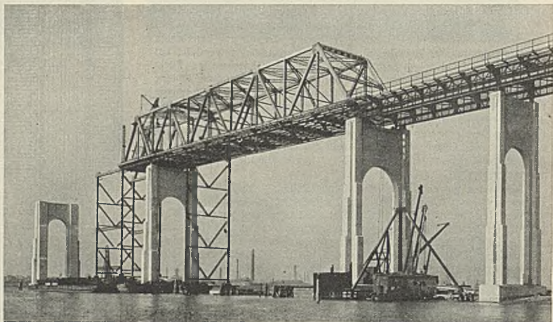
Abb. 27. Brücke über den Arthur Kill während der Montage. Die zwei eisernen Stützen in der Außenöffnung des Gerberträgers wurden zuerst in der bereits aufgerichteten Öffnung (Fachwerkträger auf zwei Stützen) verwendet.
