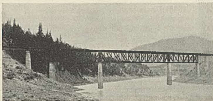
Abb. 2. Eisenbahnbrücke mit Fahrbahn oben, der Canadian Northern Pacific RR.
