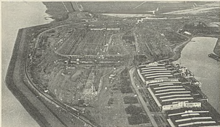
Abb. 43. Flugzeugaufnahme der Bauarbeiten im Dezember 1928.
