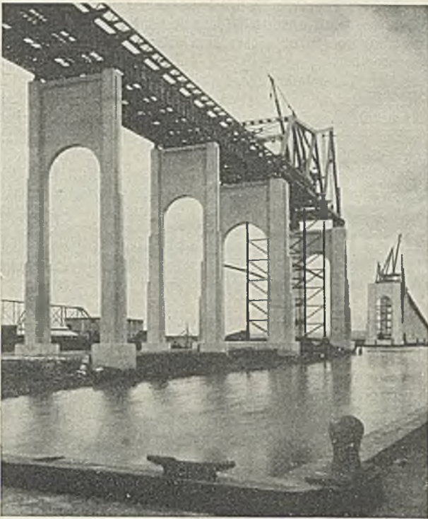
Abb. 35. Anfahrtsüberbauten (Blechträger) zur Brücke über den Arthur Kill zwischen Staten Island und New Jersey.
