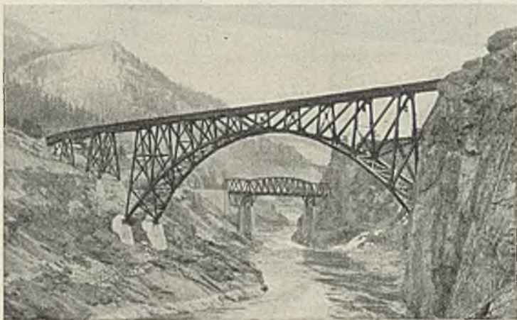
Abb. 1. Bogenbrücke der Canadian Northern Pacific RR. in Britisch Columbia. Spannweite = 130 m.
