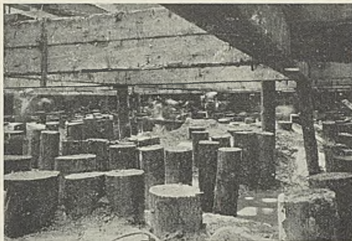
Abb. 12. Pfahlgründung eines Brückenpfeilers.
