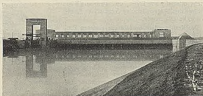
Abb. 34. Wasserschloß und Schleusenoberhaupt.
