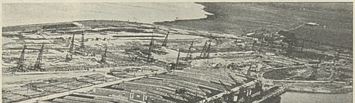
Abb. 42. Flugzeugaufnahme der Rammarbeiten im August 1928.
