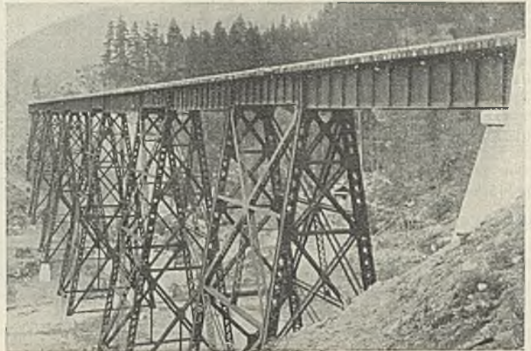
Abb. 36. Viadukt auf stählernen Stützen der Canadian Northern Pacific RR. in Britisch Columbia.
