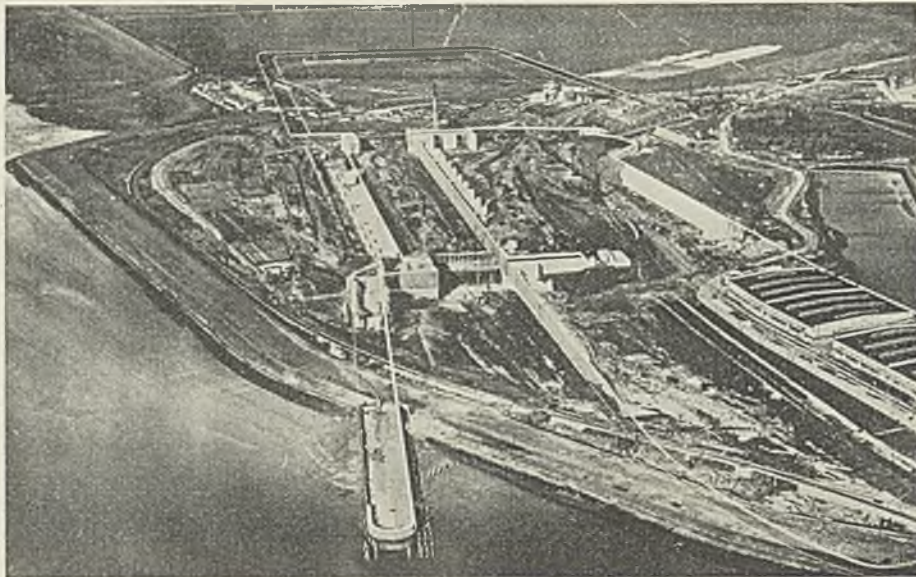
Abb. 52. Flugzeugaufnahme der Baustelle mit den Restarbeiten.
