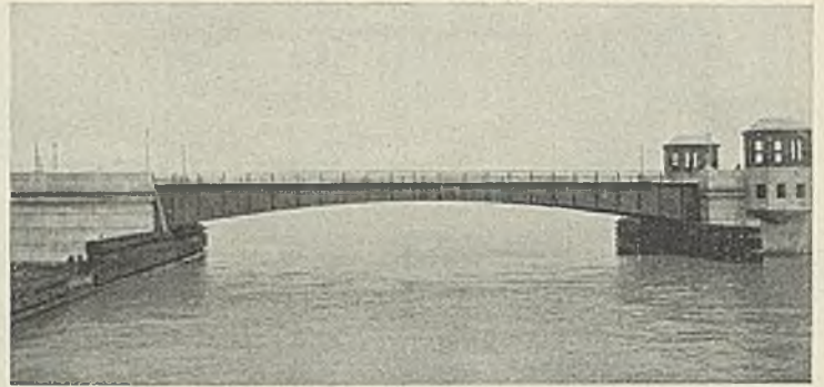
Abb. 25. Klappbrücke der Lake Pontchartrain Brücke. Straßenbreite 9,15 m. Entfernung zwischen den Drehzapfen 57,5 m, Lichtweite 46,0 m. (Das Mauerwerk ist gegen Schiffsanprall durch eine Wand aus Pfählen geschützt.)
