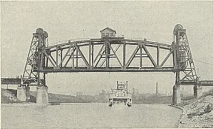
Abb. 45. Zweigleisige Hubbrücke der Pennsylvania RR. über den Ohio River in Louisville, Kentucky. Die Spannweite beträgt 81,5 m.
