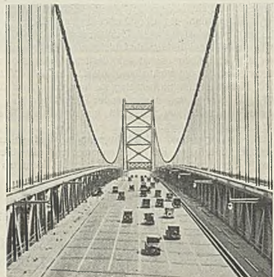
Abb. 8. Einteilung der Fahrbahntafel durch aufgemalte Längsrichtungstreifen zur Erzielung eines unbehinderten Verkehrs von Fahrzeugen nach beiden Richtungen.
