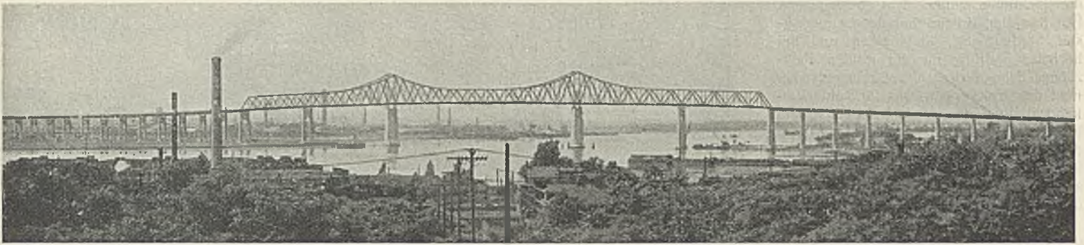
Abb. 4. Brücke über den Arthur Kill zwischen New Jersey und Staten-Island, New York.
