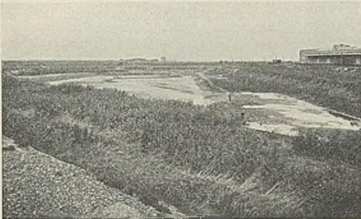
Abb. 39. Zustand der Baugruben im Außenvorhafen vor Beginn der Erdarbeiten. Januar 1928.
