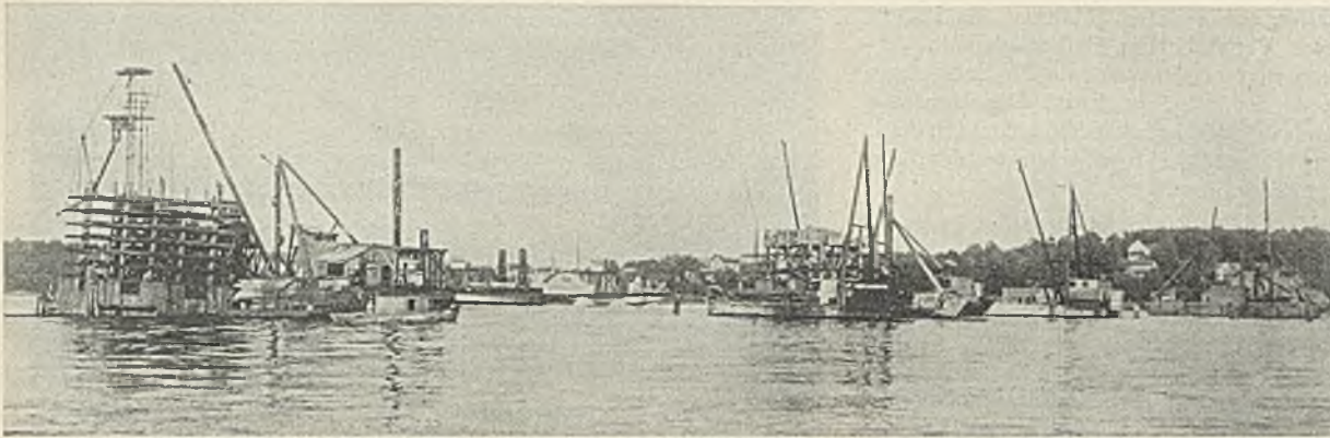
Abb. 21. Eine Übersicht der Gründungsarbeiten bei der Brücke über den Kennebec River.
