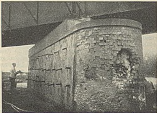
Abb. 6. Pfeiler 7. Nordseite mit durchstoßenem Mauerring.
