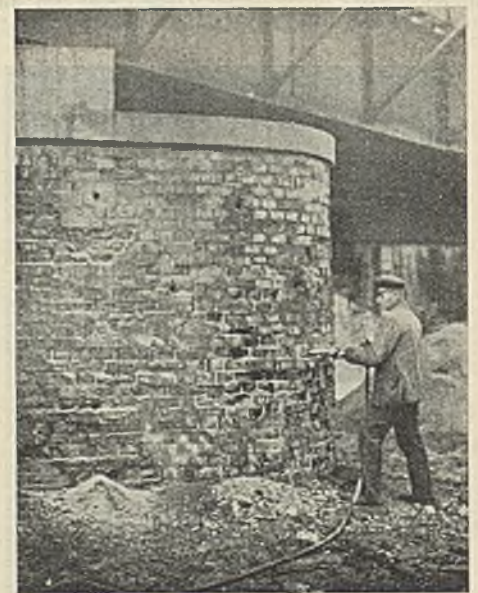
Abb. 8. Bearbeiten mit Preßluftmeißel.
