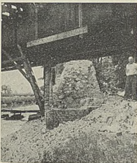
Abb. 4. Pfeiler 3. Nordseite. Beginn des Abbruches.
