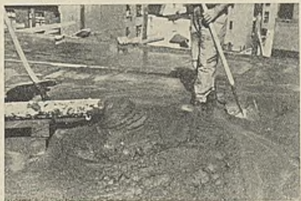
Abb. 2. Ausfluß des Betons aus der Rohrleitung.
