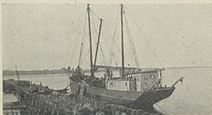
Abb. 7. Herstellung der Steinpackung.
