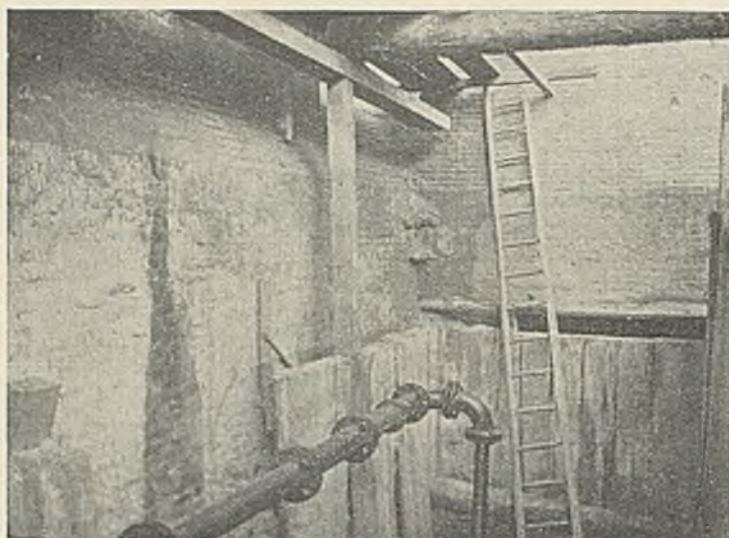
Abb. 7. Beobachtungsschacht A. Spundwand ist freigelegt und teilweise weggenommen.
