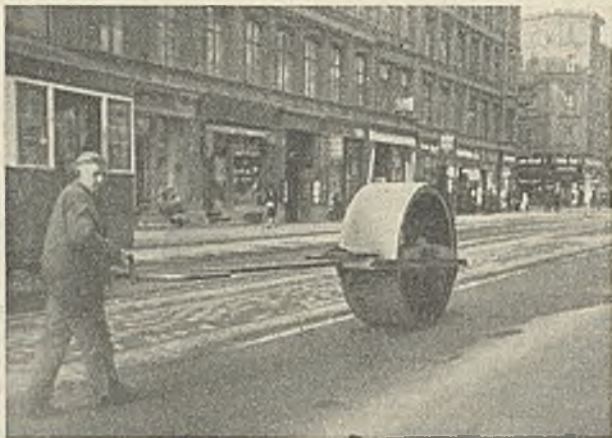
Schwartzkopf-Einradmotorwalze.
