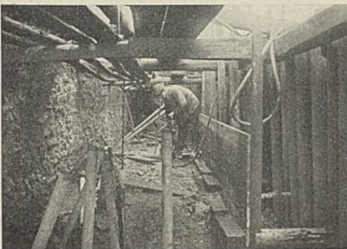
Abb. 18. Klodnitzkanalbrücke. Westwiderlager. Baugrube.
