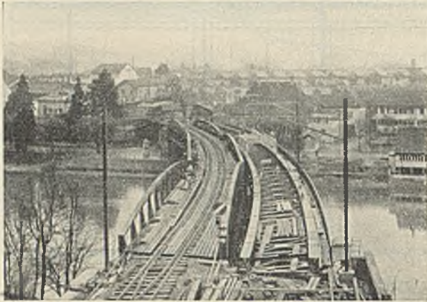
Abb. 11. Beginn des Betonierens der Fahrbahnplatte. Schutzgerüst gegen Kälteeinwirkungen. Links alte Überbauten.
