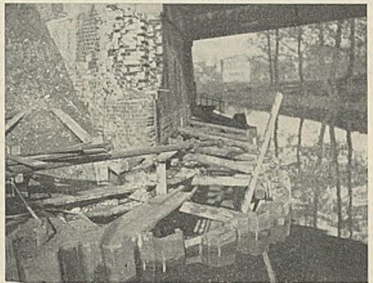
Abb. 16. Klodnitzkanalbrücke. Westwiderlager. Spundwand für Abbruch der Treidelmauer.
