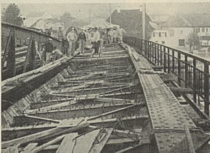
Abb. 8. Draufsicht auf die Fahrbahn mit den Eisenbewehrungen.
