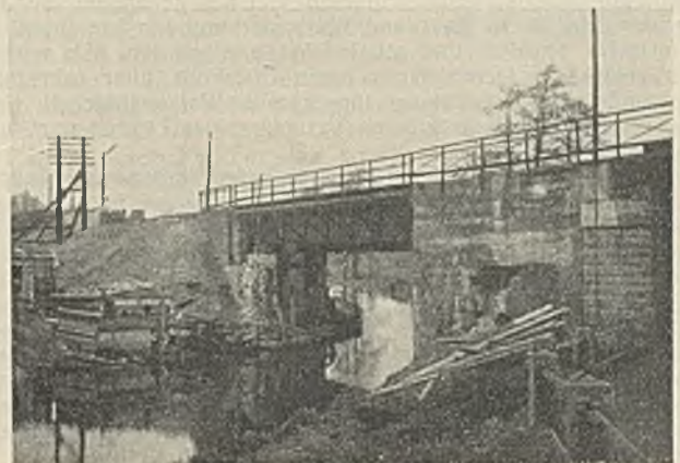
Abb. 19. Klodnitzkanalbrücke mit anschließender Straßenunterführung.
