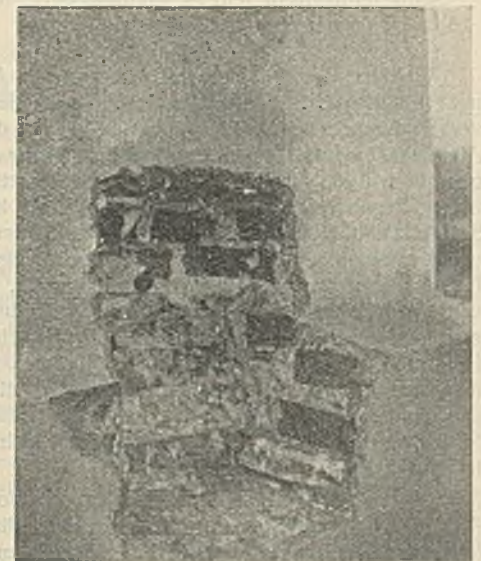
Abb. 14. Pfeiler 4. Probeloch zum Nachweis der Wirkung.
