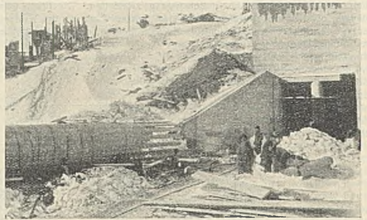
Abb. 6. Einmündung der Rohrleitung in den Stollen.
