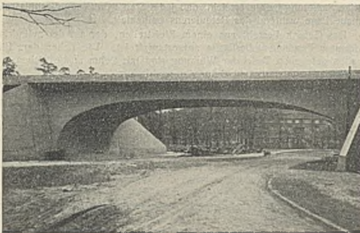
Abb. 1. Brücke 3. L. Weite 22 m.
