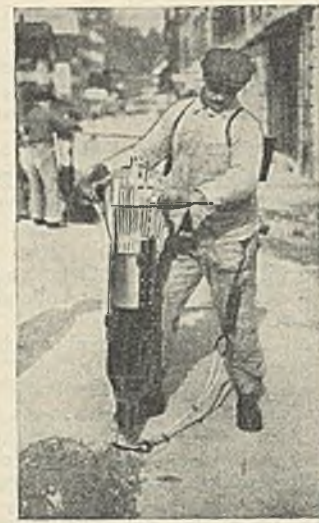
Abb. 3. Explosions-Aufbruchmeißel.
