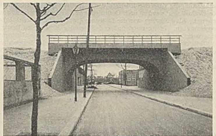
Abb. 2. Brücke 1. L. Weite 13 m.
