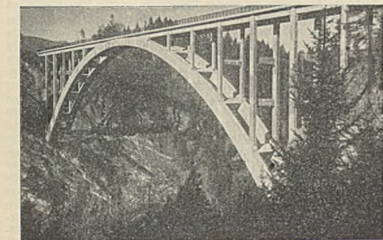
Abb. 22. Die fertige Eisenbetonkonstruktion.
