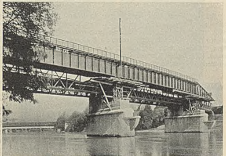
Abb. 25. Die neuen Überbauten sind über dem 2. Pfeiler angelangt.
