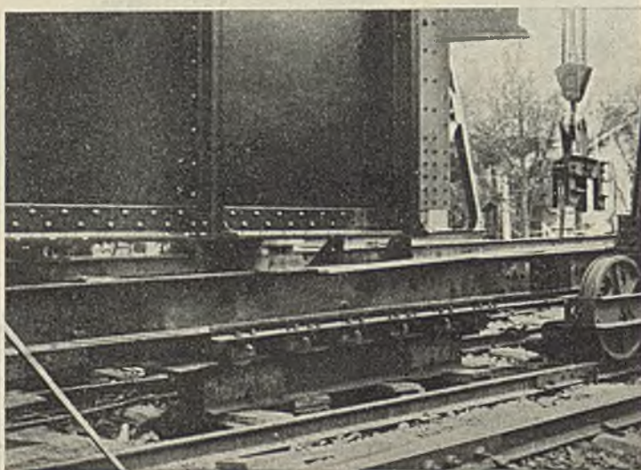
Abb. 27. Verschiebewagen am hinteren Ende der Hauptträger.
