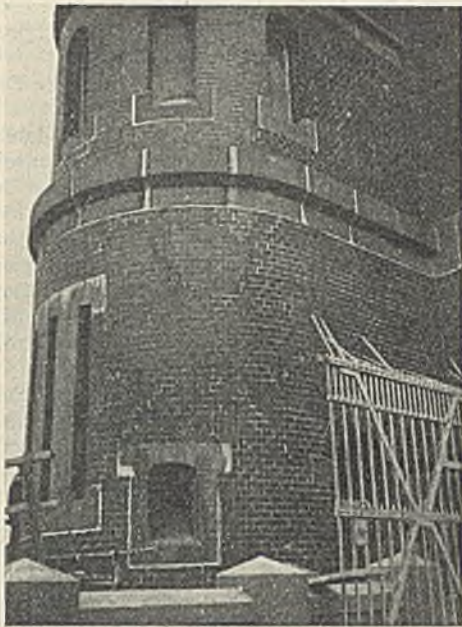
Abb. 7. Nördliches Widerlager nach der Instandsetzung.
