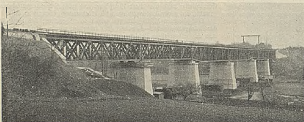
Abb. 19. Das fertige Bauwerk.
