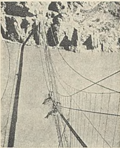
Abb. 1. Tragkabel der Kaibabbrücke.
