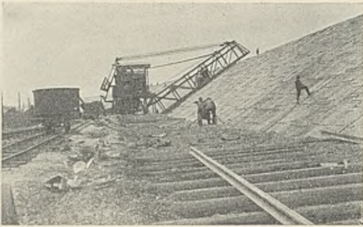
Abb. 4. Abdeckung der betonierten Böschung.
