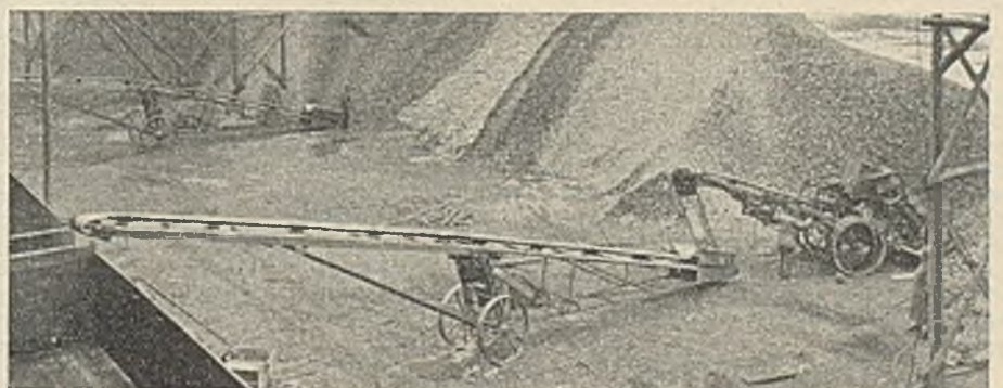
Abb. 1. Selbsttätiges Aufnahmegerät für ein fahrbares Förderband.
