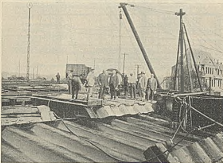
Abb. 12. Einbringen der neuen Mittelträger. Bauabschnitt I.
