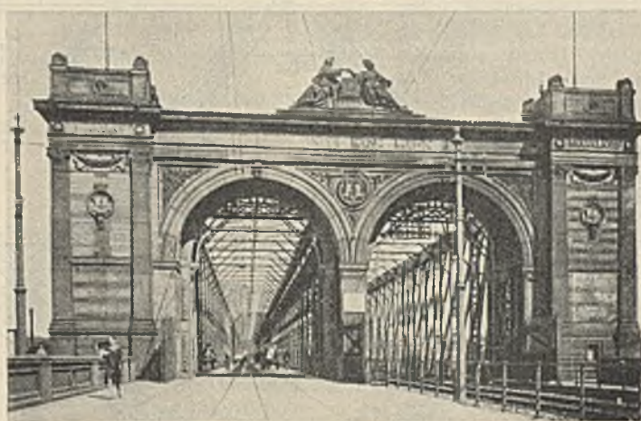
Abb. 2. Brückenportal der alten Brücke.
