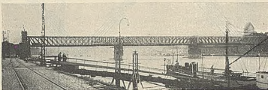
Abb. 1. Ansicht der alten Brücke.
