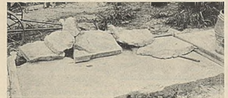
Lagenbetondecke: obere Schicht entfernt.
