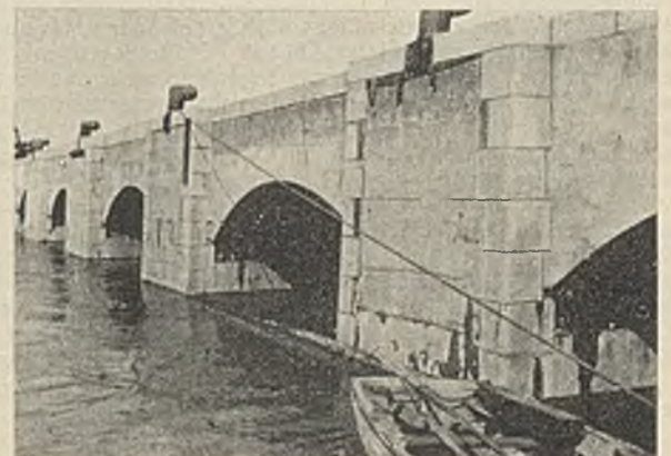
Abb. 14. Blick auf die fertige Mauer vom Wasser aus.
