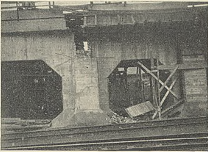
Abb. 13. Erneuerung der Fahrbahn an den Stellen der alten Querträger.
