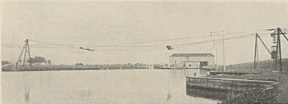
Abb. 1. Seiltreidelanlage im Oberwasser.
