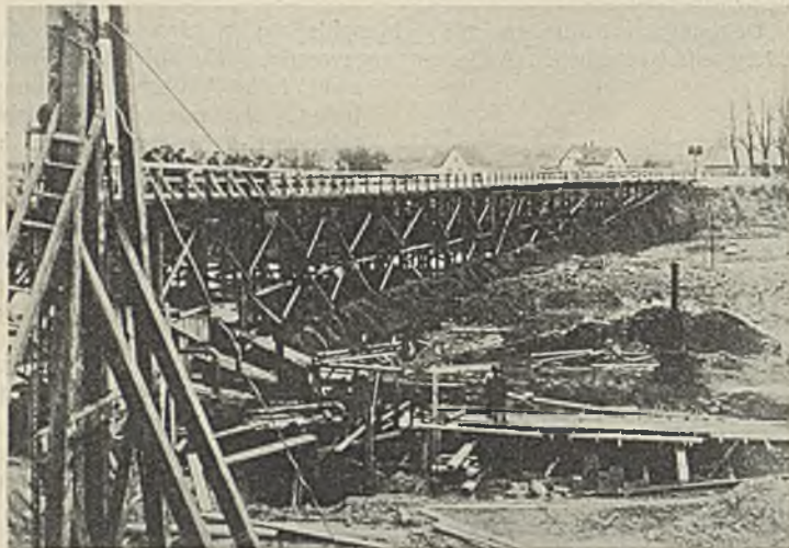
Abb. 13. Notbrücke auf dem rechten Vorlande.
