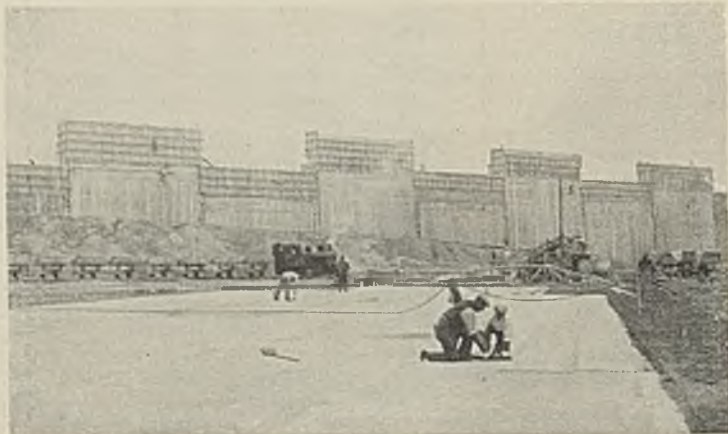
Abb. 13. Beckensohlendichtung: Aufbringen der „Kaltelastik-Dichtung“.
