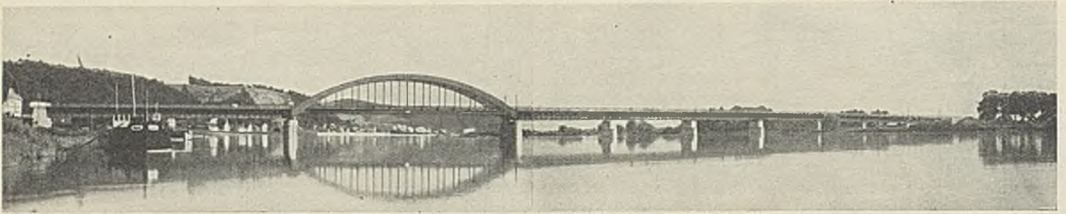
Abb. 14. Neue Brücke. Gesamtansicht.
