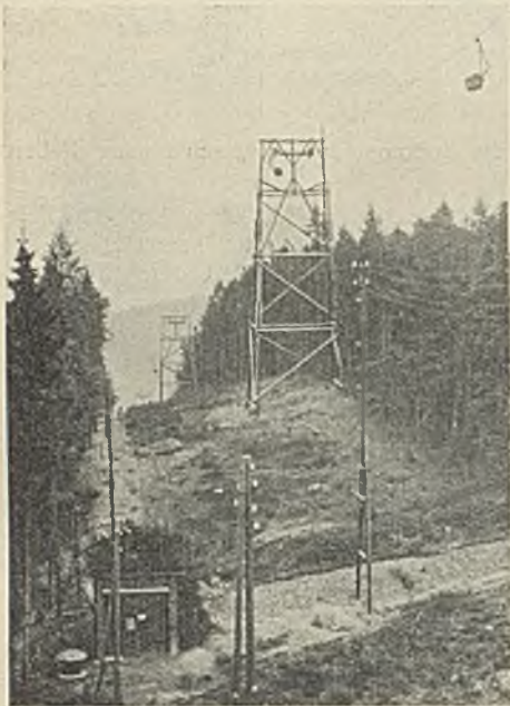
Abb. 5. Speicherkraftwerk Bringhamen. Seilbahnstrecke.
