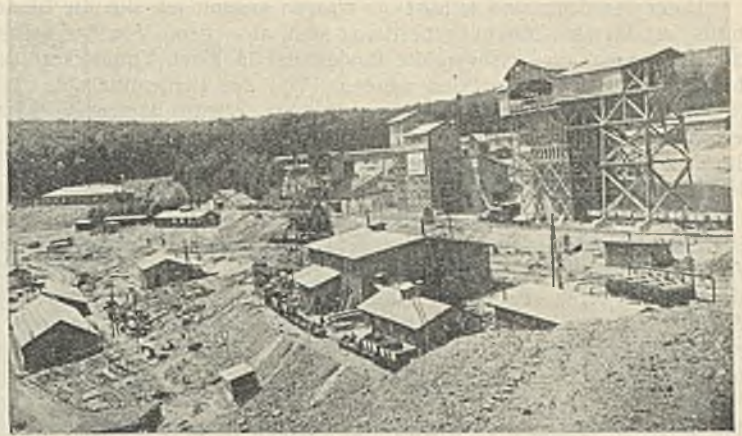
Abb. 9. Baustelleneinrichtung: Brech- und Mahlanlage, Seilbahn mit Zementsilos.
