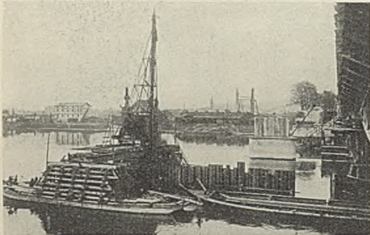
Abb. 6. Rammen der Larssenwand am Pfeiler 4.
