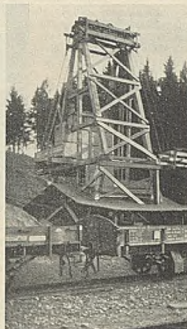
Abb. 12. Förderturm am Schacht Fellach des Münchener Wasserleitungsstollens, Los I. 16 m hoch, 8500 kg Tragkraft.
