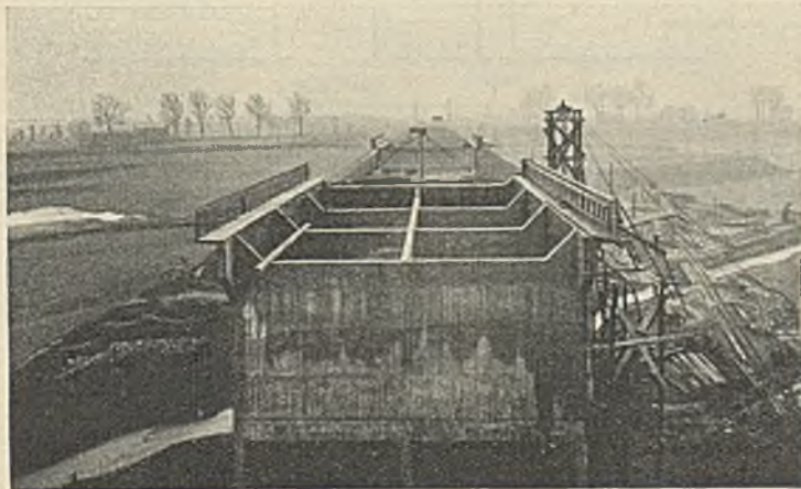
Abb. 9. Unterführung des Beuthener Wassers. Blick von oben in Richtung Gleiwitz.
