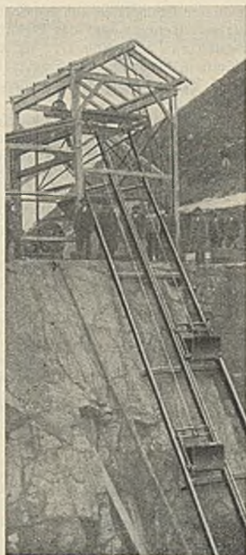
Abb. 11. Doppelter Kippkübel-Schrägaufzug.
