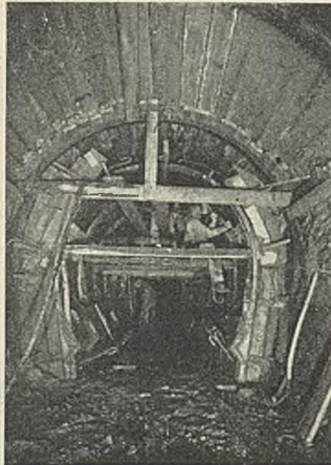
Abb. 10. Stollenbauweise Hüser. Betonieren mit Preßluftstamper und Bewehren.
