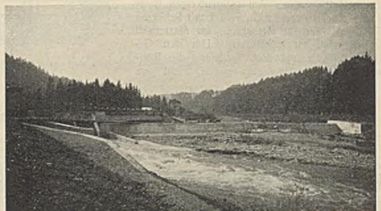
Abb. 29a. Wehr bei Oberneumühle von der Unterwasserseite aus. Spülkanal in Tätigkeit.
