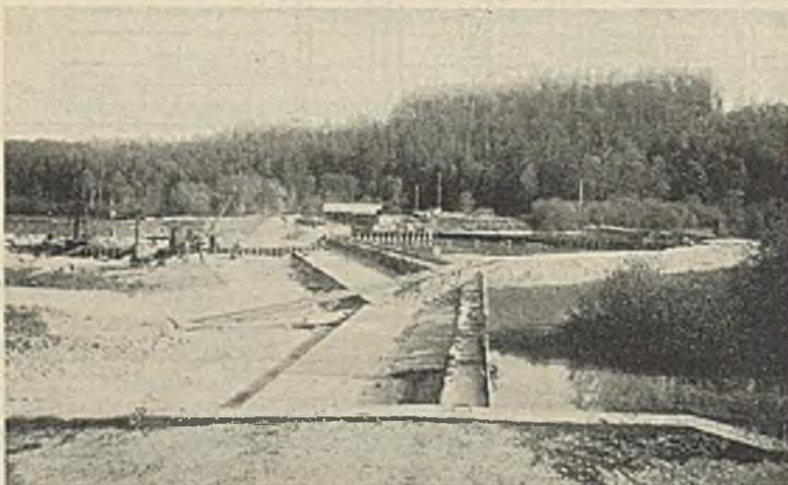
Abb. 29. Altes Wehr mit Fangdamm und Spundwand für das Einlaufbauwerk.
