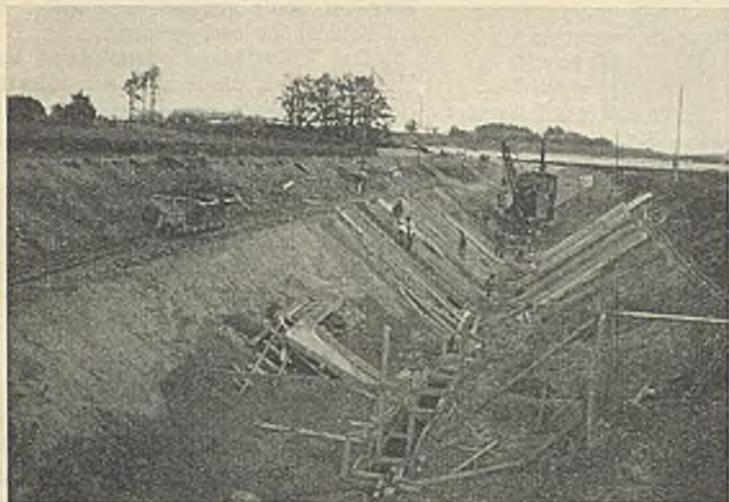
Abb. 27. Betonieren des Auslaufkanals.
