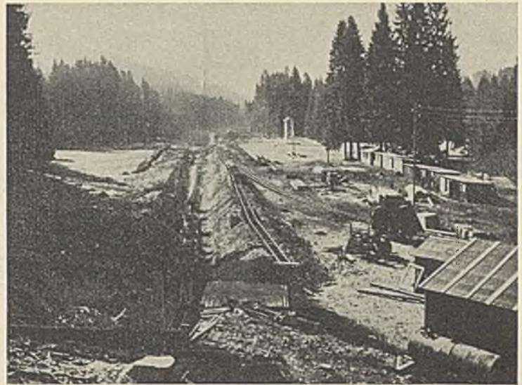
Abb. 31. Oberwasserkanal im Anschluß an Stollenmundloch A.
