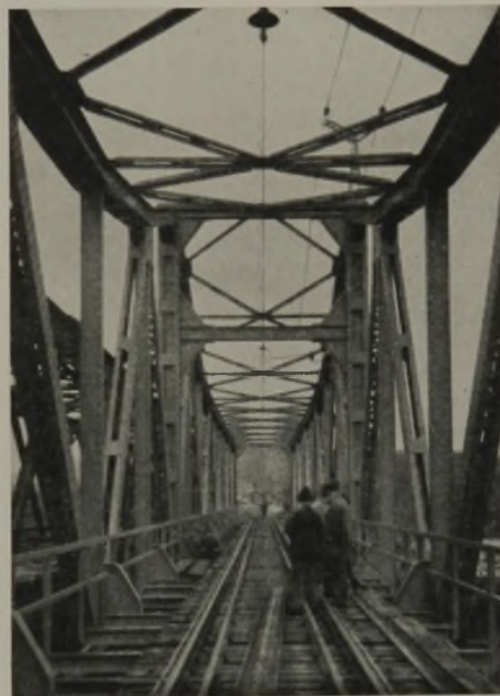
Abb. 4c. Ansicht des Portales der neuen Brücke beim Mittelpfeiler.
