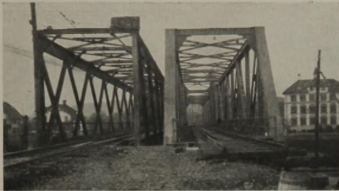
Abb. 4a. Ansicht der alten und neuen Brücke. Endportale.
