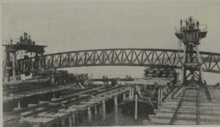
Abb. 5. Absetzen eines halben Bogens auf Kähne zum Einschwimmen.
