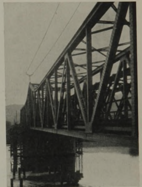
Abb. 4d. Seitenansicht der Hauptträger der neuen Brücke.
