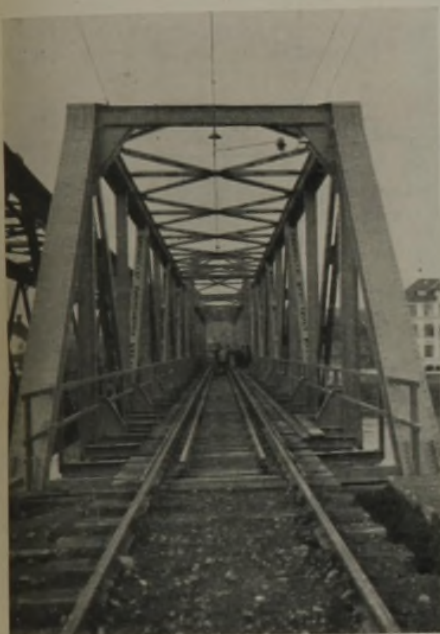
Abb. 4b. Innenansicht der neuen Brücke beim Endportal.
