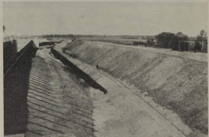
Abb. 15. Schleuse Hünxe. Hinterfüllungsarbeiten in zwei Kippebenen.
