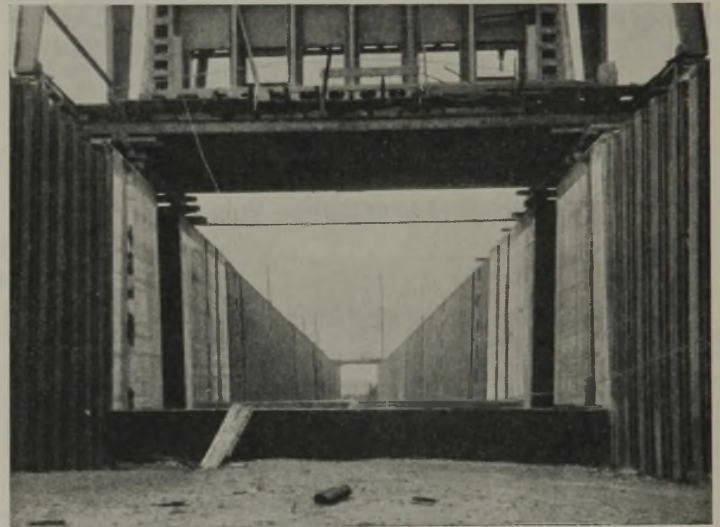
Abb. 10. Schleuse Hünxe. Gesamtansicht der Kammer vom Unterpaupt gesehen. Die Holme auf den Spundwänden sind noch nicht angebracht. Die Montage der Hubtore ist in Angriff genommen.
