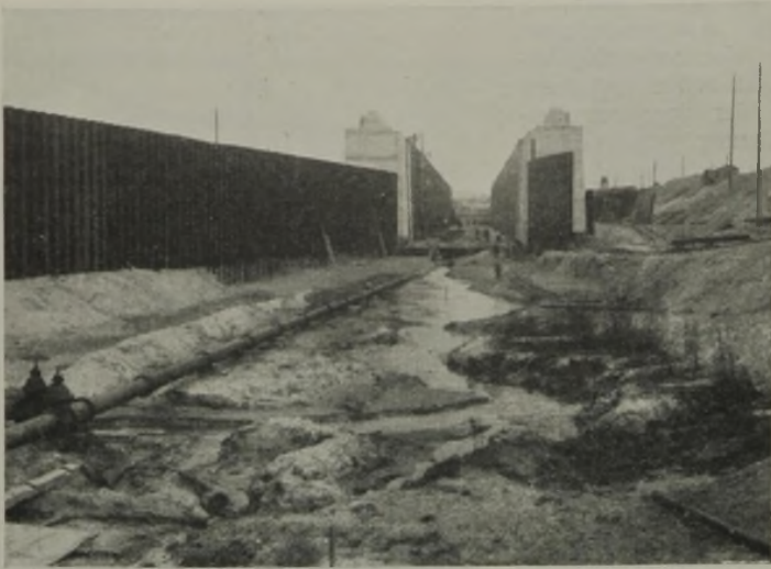
Abb. 16. Schleuse Hünxe fertig betoniert und gerammt, vom Unterhaupt aus gesehen. Im Vordergrund die Leitwerkswände aus Larsseneisen.
