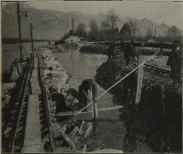
Abb. 15. Ansetzen der Böschung. Die Vorgrundschüttung vollendet.
