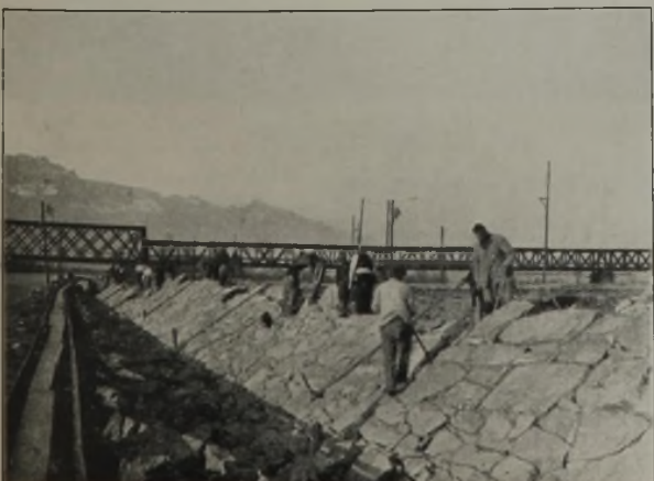
Abb. 17. Pflasterung der Wasserseite.
