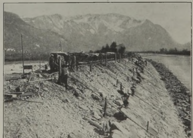
Abb. 21. Anschüttung und Pflasterung.
