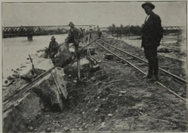
Abb. 20. Anschüttung des neuen Dammes.
