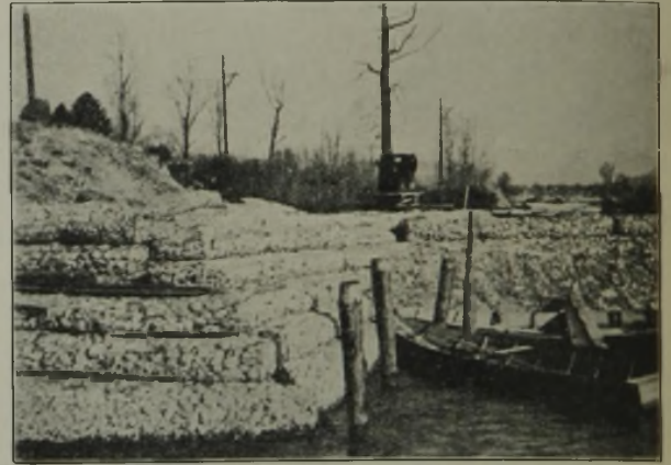
Abb. 23. Steinwalzen und Pfähle als Dammschutz.
