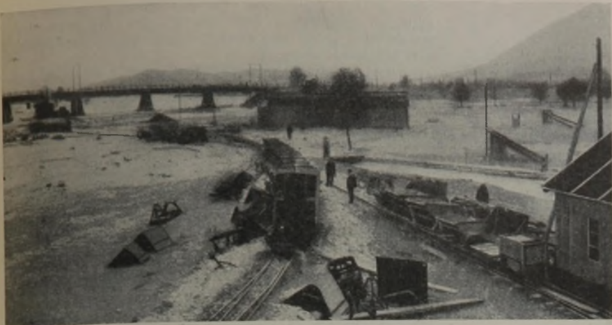
Abb. 13. Baustelle „Wiesengasse“. Im Hintergrund das Brückenprovisorium der österreichischen Bahnlinie Buchs—Feldkirch; links Zugseilbagger in der Trasse des zugeschütteten Binnenkanals und rechts Lokomotivschuppen. Im Vordergrund ein Materialzug des „Kanal“-Betriebes und rechts Wagenwerkstatt.
