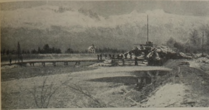
Abb. 6. Blick in das Rheintbett: Wasserrinne mit Transportsteg, unterer Dammkopf, Anschluß an Behelfs-Damm. 19. Dezember 1927. Temperatur -12^{\circ} C.
