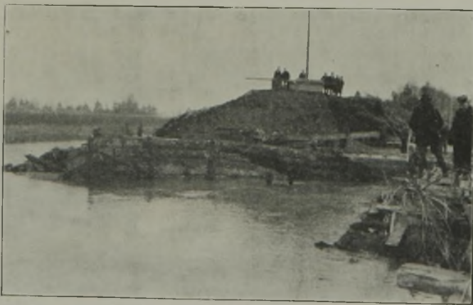
Abb. 5. Ansicht des oberen Wuhrdammes mit Sicherung durch Drahtsteinwalzen.
