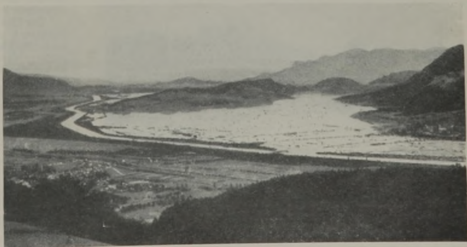
Abb. 1. Überschwemmung der Ebene bei Schaan bis zum Schellenberg nach dem Dambruch vom 25. September 1927.
