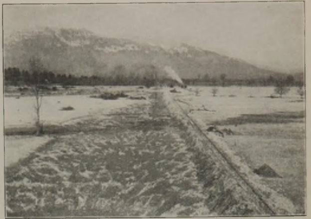
Abb. 8. Kiesablagerungen auf dem überschwemmten Gebiet.
