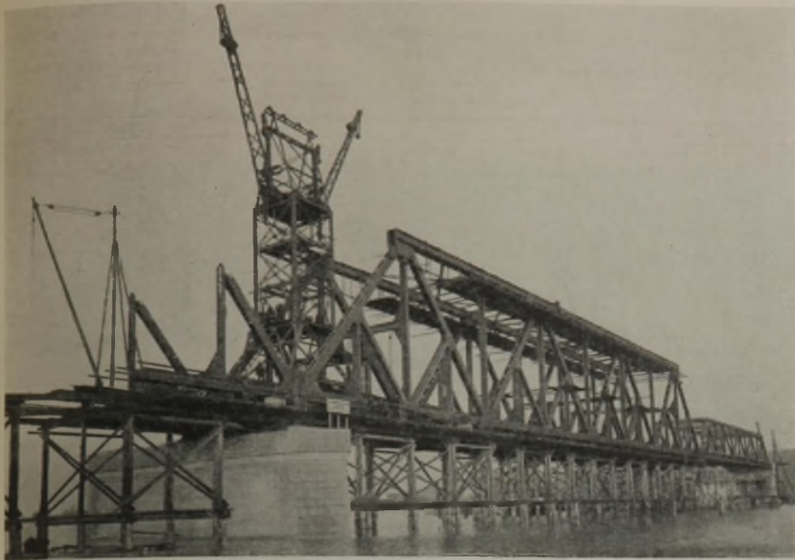
Abb. 41. Ostoderbrücke. Vorstreckkran über dem westlichen Strompfeiler.
