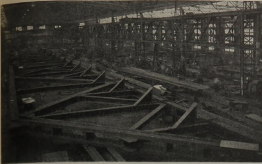
Abb. 19. Westoderbrücke. Hauptträger des Mittelüberbaues in der Werkstatt.
