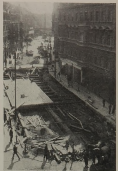
Abb. 15. Untergrundbahnbau mit Tiefbrunnensenkung in der Alexanderstraße zu Berlin. (Rampenstrecke der neuen Spreekreuzung an der Jannowitzbrücke.) Blick in die Alexanderstraße in Richtung Jannowitzbrücke während des Einbaues der behelfsmäßigen Baugrubendecke.
