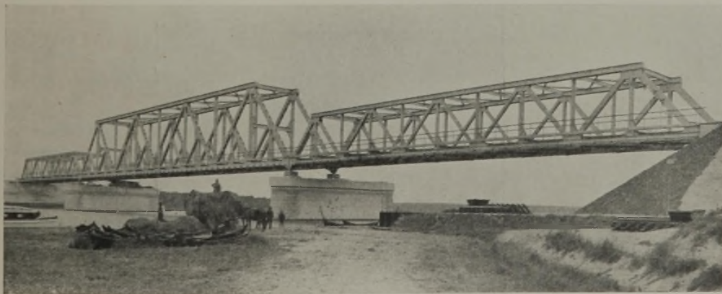
Abb. 45. Ostoderbrücke nach Fertigstellung, von Südosten aus gesehen.
