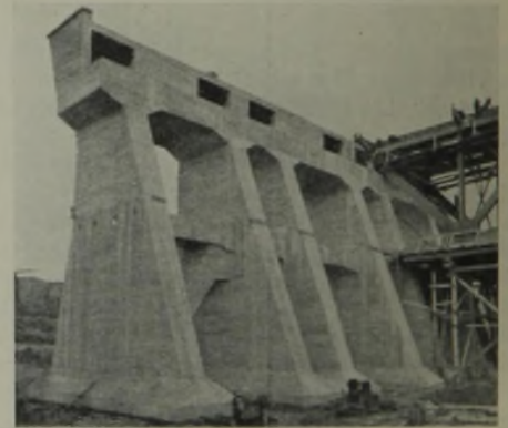
Abb. 12. Westoderbrücke. Westliches Widerlager nach der Ausschaltung. (Vom Wasser aus gesehen.)
