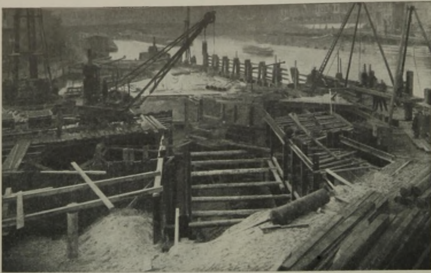
Abb. 32. Schnellbahn Gesundbrunnen—Neukölln, Los XIX, Spreetunnel. Bauabschnitt linke Spreeseite. Die Grundwasserabsenkung durch Tiefbrunnen in den Fangedämmen ist im Gange. Bohren weiterer Tiefbrunnen.
