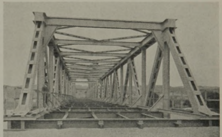
Abb. 44. Ostoderbrücke. Durchblick von Westen aus.
