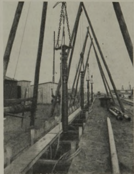
Abb. 27. Ausbesserung des Dockes VI in Kiel. Eine Serie von SSW-Tauchpumpensätzen fertig zum Einbau über den zugehörigen Brunnenreihen. In dem Holzkasten neben den Brunnen sind die Anschlußkabel für die Tauchpumpensätze geführt, darunter die Abflußleitung, an die die Druckrohre der Pumpen angeschlossen werden.
