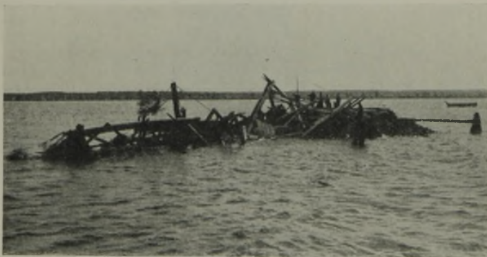
Nach der Sprengung.
