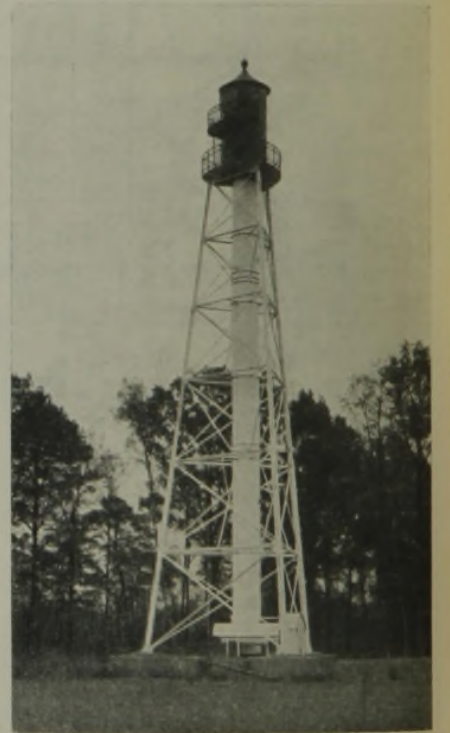
Abb. 24. Ansicht des Gnageland-Oberfeuers.
