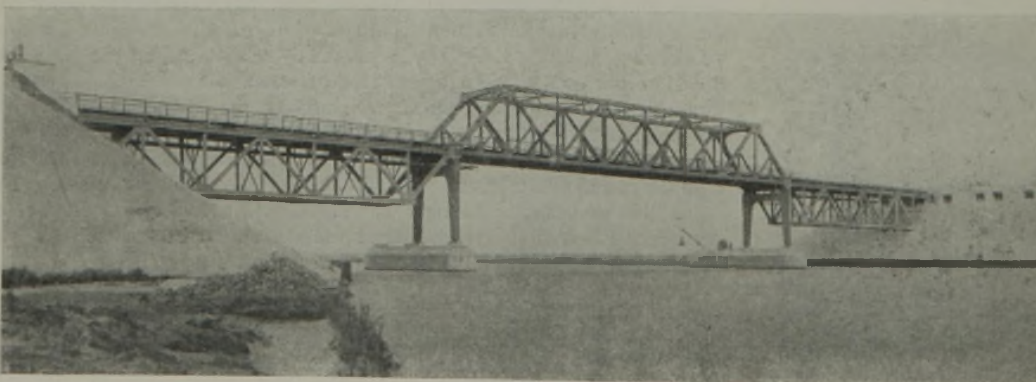
Abb. 29. Westoderbrücke nach Fertigstellung. (Vom südwestlichen Ufer aus gesehen).
