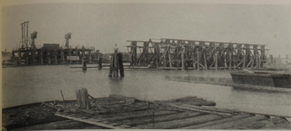
Abb. 14. Westoderbrücke. Blick auf die Baustelle der Strompfeiler von Norden aus.
