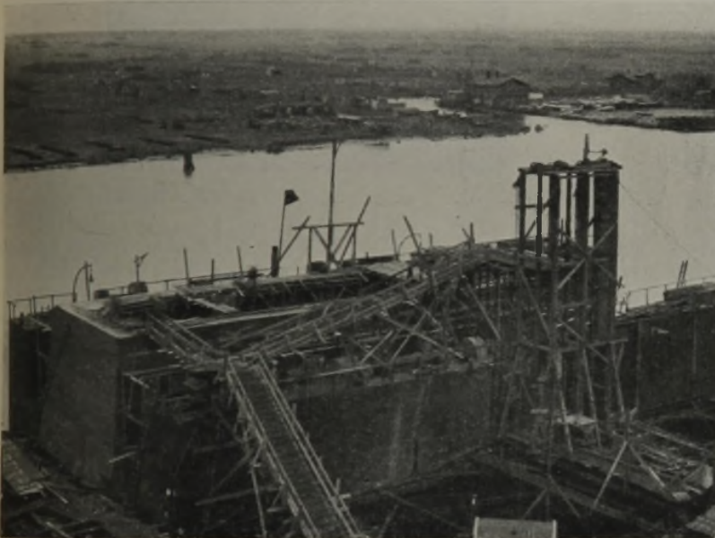
Abb. 33. Ostoderbrücke. Senkkasten eines Strompfeilers im Dock des „Vulcan“.
