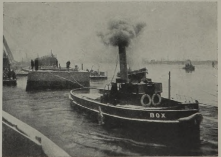
Abb. 35. Ostoderbrücke. Abschwimmen des Senkkastens nach der Baustelle.
