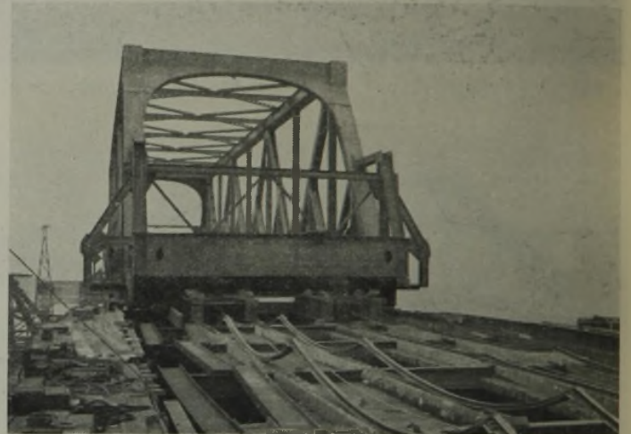
Abb. 28. Westoderbrücke. Mittelüberbau während des Verschiebens. (Von Westen gesehen.)
