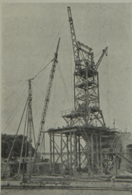
Abb. 39. Ostoderbrücke. Vorstreckkran vor Beginn der Aufstellung des östlichen Überbaues.
