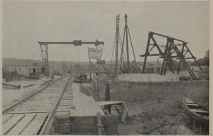
Abb. 31. Ostoderbrücke. Aufstellung der Bremsböcke im östlichen Widerlager. Portalkran über dem Baugleise.
