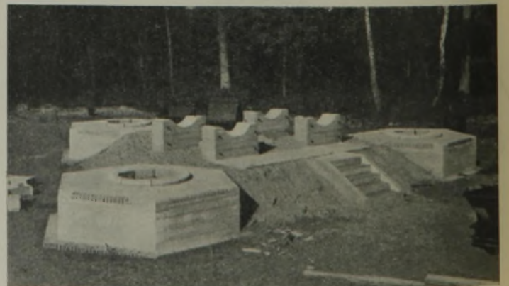
Abb. 23. Unterbau des Gnageland-Oberfeuers vor dem Aufstellen der Bake.
