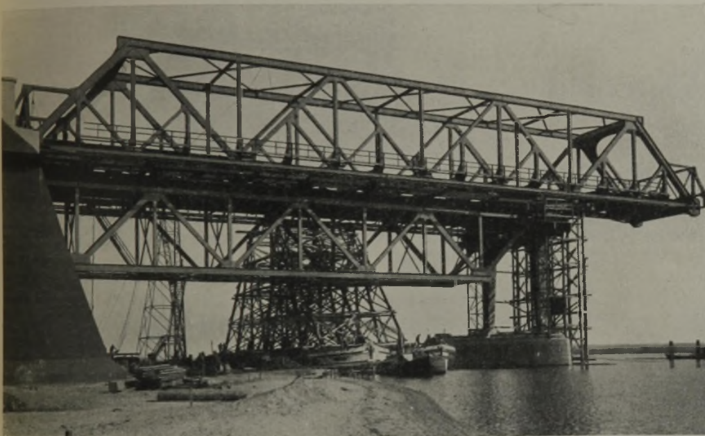
Abb. 22. Westoderbrücke. Mittelüberbau vor dem Einschleiben.
