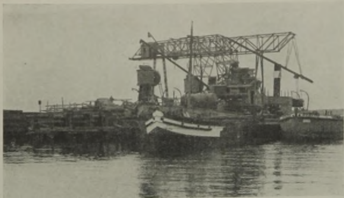
Abb. 36. Ostoderbrücke. Einrichtung der Baustelle am östlichen Strompfeiler.
