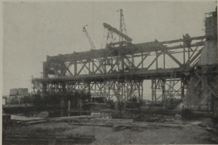
Abb. 16. Westoderbrücke. Aufstellung des westlichen Überbaues.
