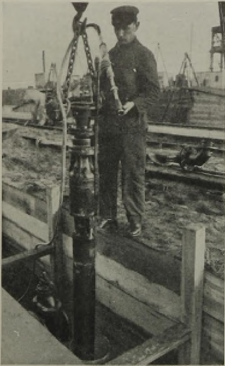
Abb. 28. Ausbesserung des Dockes VI in Kiel. Anschluß eines SSW-Tauchpumpensatzes an das Zuleitungskabel; über dem langgestreckten Motor, der bereits 1 Stück in das Brunnenrohr herabgelassen ist, die Kreiselpumpe.
