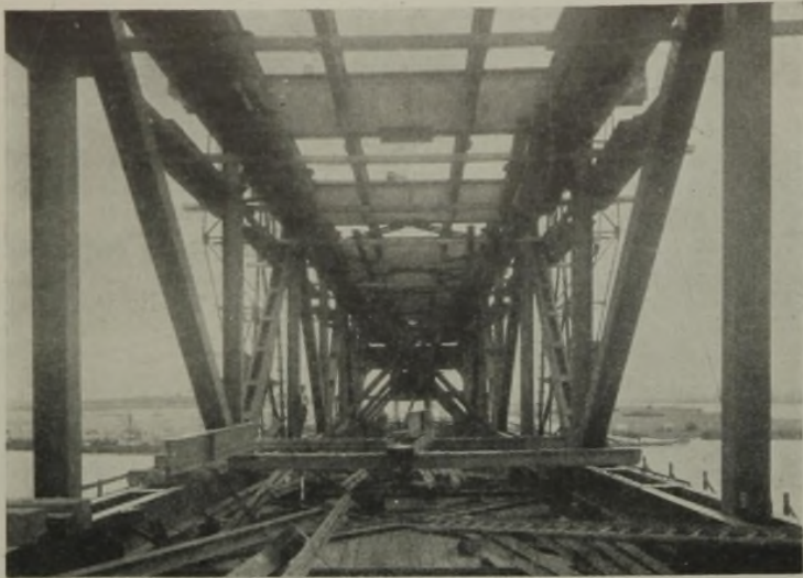
Abb. 17. Westoderbrücke. Durchblick durch den westlichen Überbau. (Vom Lande aus gesehen.)
