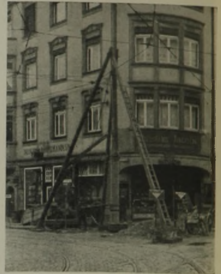
Abb. 35. Kanaltunnel Köln-Mülheim. Brunneneinbau an der Kreuzung mit der Düsseldorfer Straße.
