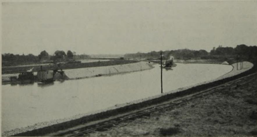
Abb. 3. Greifer und Löffelbagger bei der Arbeit.
