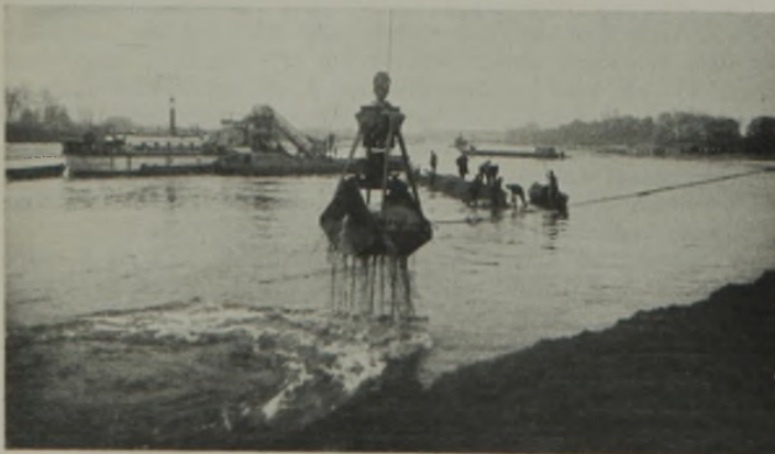
Abb. 4. Beseitigen des oberen Abschlußdeiches.
