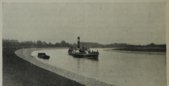
Abb. 5. Ansicht des Durchstiches nach Fertigstellung.
