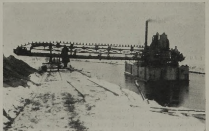
Abb. 1. Schwimmender Eimerkettendampfbagger mit Überleiter.
