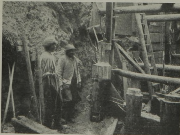
Abb. 4. Rammarbeiten in der Baugrube des linken Widerlagers.
