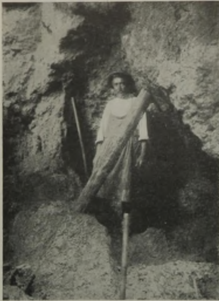
Abb. 3. Aushöhlung im Tuffstein. (Rückwand des linken Widerlagers.)
