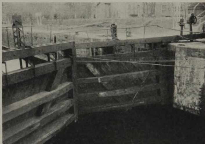
Abb. 6. Aufnahme des Untertores aus dem Jahre 1926. Das obere Halslager des linken Flügels (auf dem Bilde rechts) war infolge Anfahrens gebrochen, daher hängt der Flügel geneigt.
