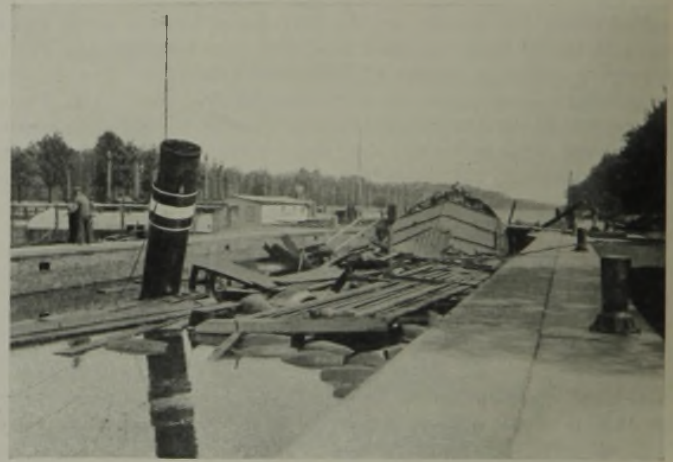
Abb. 4. Ansicht bei gefüllter Kammer nach Setzen des unteren Notverschlusses.
