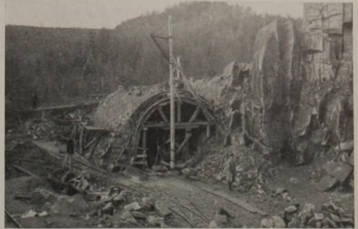
Abb. 4. Steinbruchwegunterführung bei Baustation 26 + 50.
