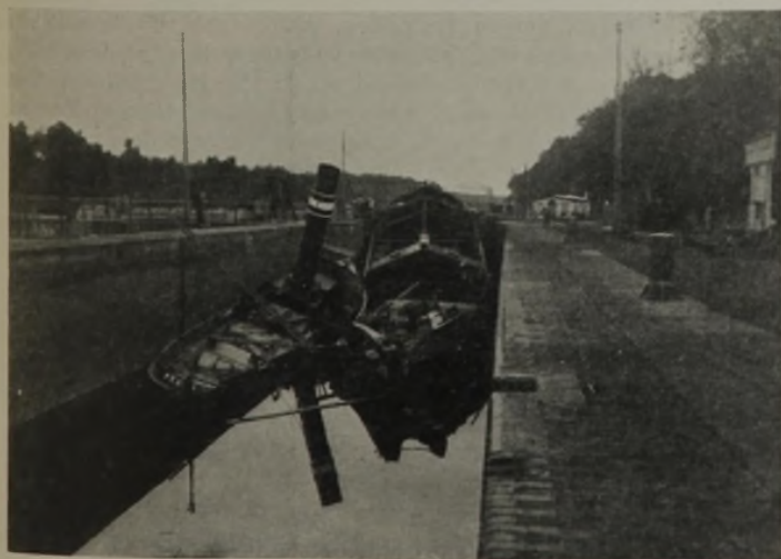
Abb. 1. Lage der Fahrzeuge nach dem Unfall. Die obere Notdichtung ist eingebracht. Der Wasserstand in der Schleuse steht auf Unterwasser.
