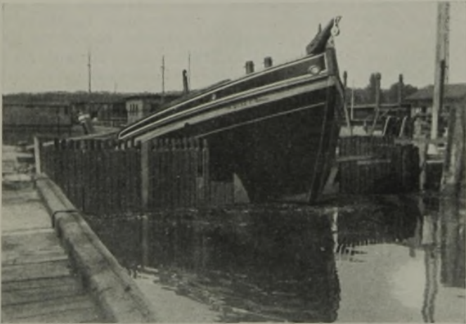
Abb. 3. Vordersteven des Kahnes auf dem Oberdrempel aufsitzend, mit oberem Notverschluß, vom Oberwasser aus gesehen.
