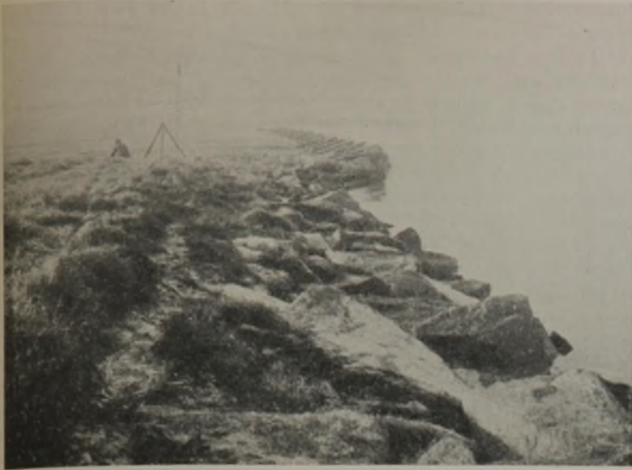
Abb. 2. Leitwerk des Tessin an der Mündung in den Langensee mit angehängter Holzwand.
