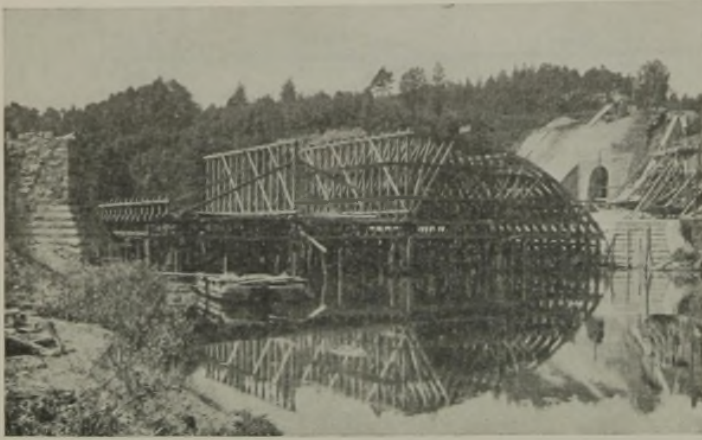
Abb. 17. Lehrgerüst des großen Bogens im Bau (Juli 1928).
