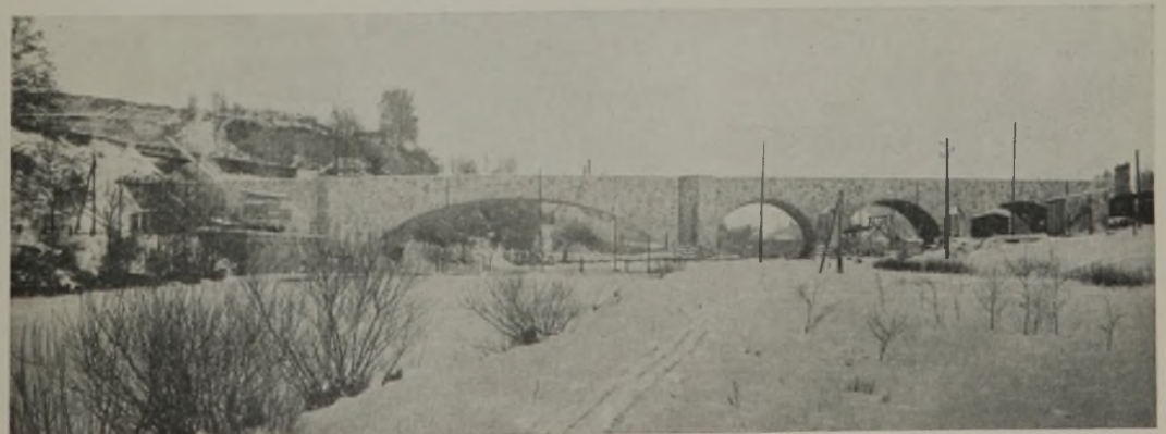
Abb. 10. Gesamtansicht der Muldenbrücke und Eisenbahnüberführung (links oben) nach dem Stande vom Januar 1929.
