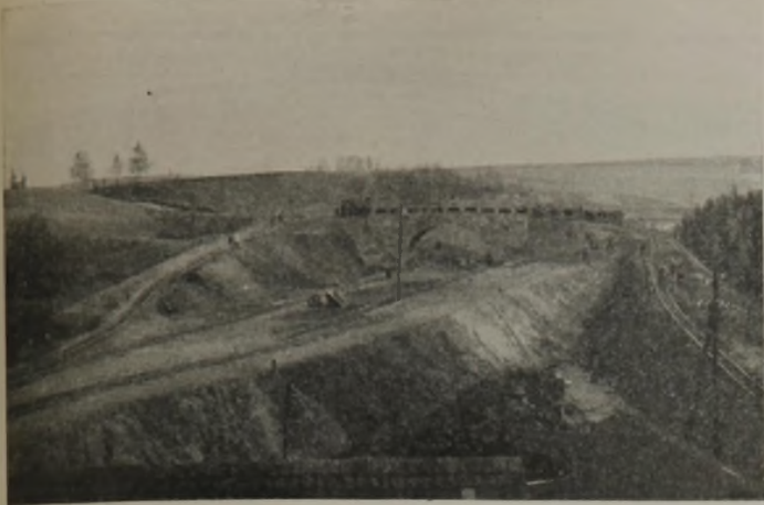
Abb. 8. Brücke bei Baustation 29 mit Rampen im Bau.
