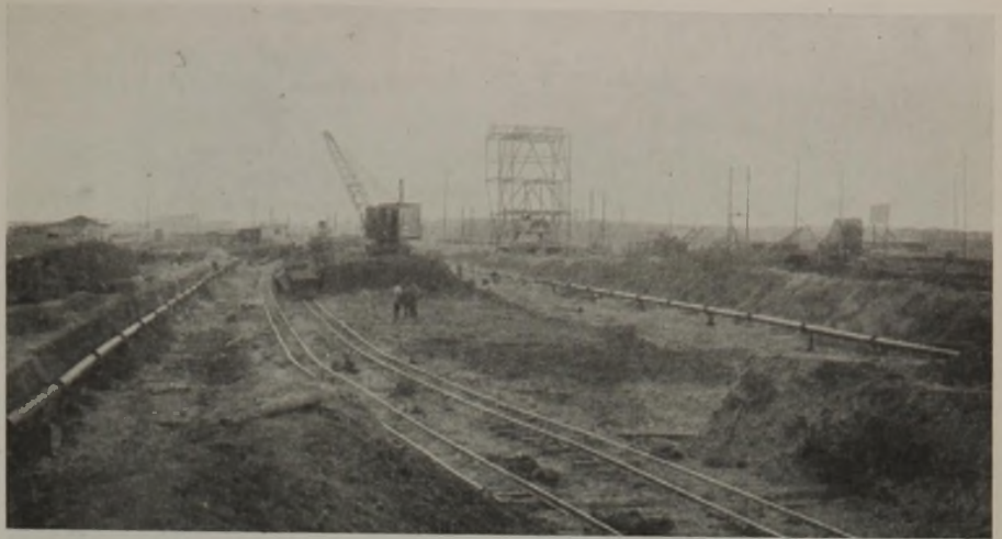
Abb. 13. Bodenaushub und Verlegen der Saugleitungen.
