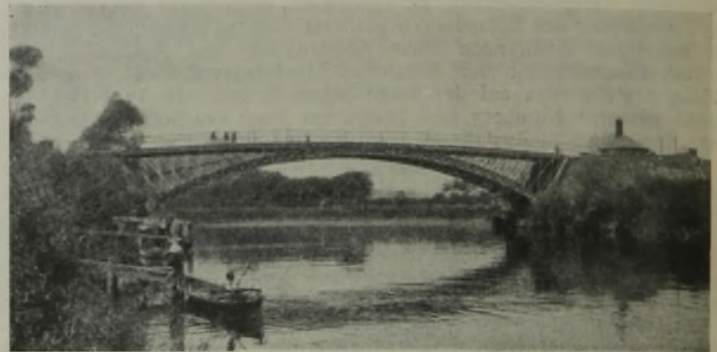
Abb. 1. Holt-Fleet-Brücke vor dem Umbau.
