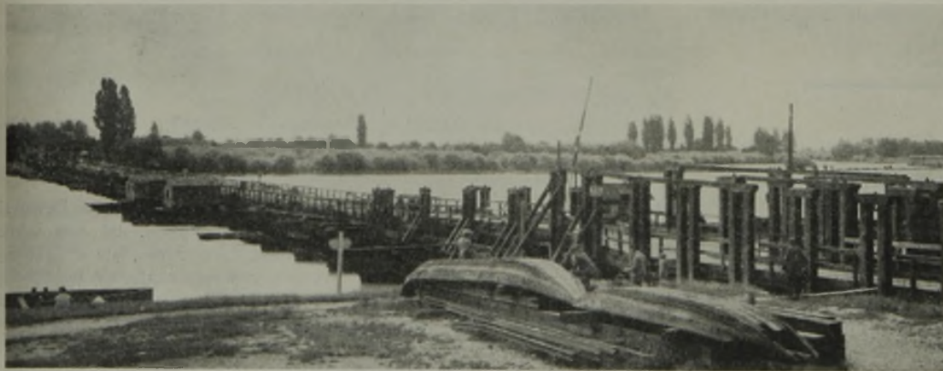
Abb. 1. Eisenbahn- und Straßen-Schiffbrücke bei Speyer.
