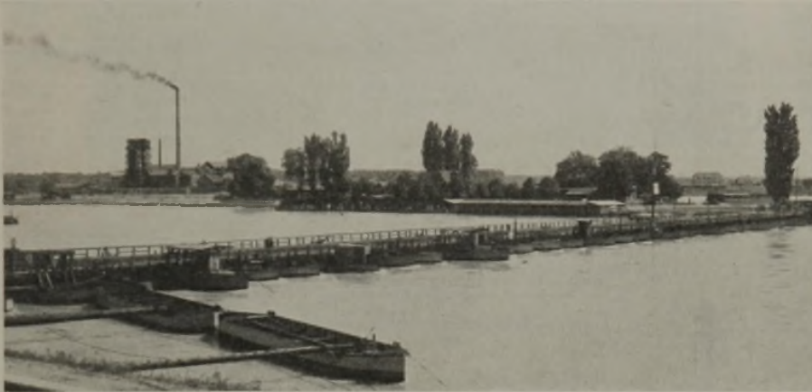
Abb. 1. Eisenbahn- und Straßen-Schiffbrücke bei Maxau.
