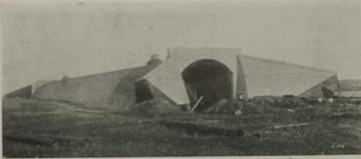
Abb. 25. Ansicht des fertigen Bauwerks.
