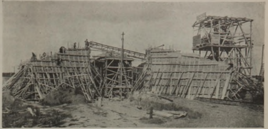
Abb. 21. Betonieren der Flügelmauern.
