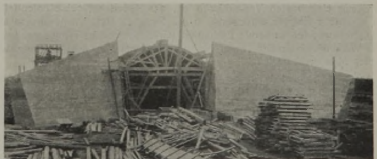
Abb. 24. Ausgeschaltete Flügelmauern und Gewölbemauerung.
