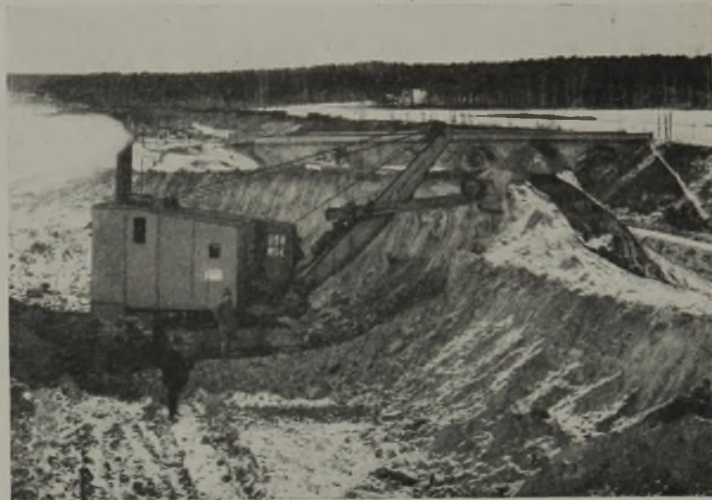
Abb. 4. Neuzeitlicher Bagger beim Abgraben hinter der Lichtenberger Brücke. Die Tone stehen fast senkrecht.
