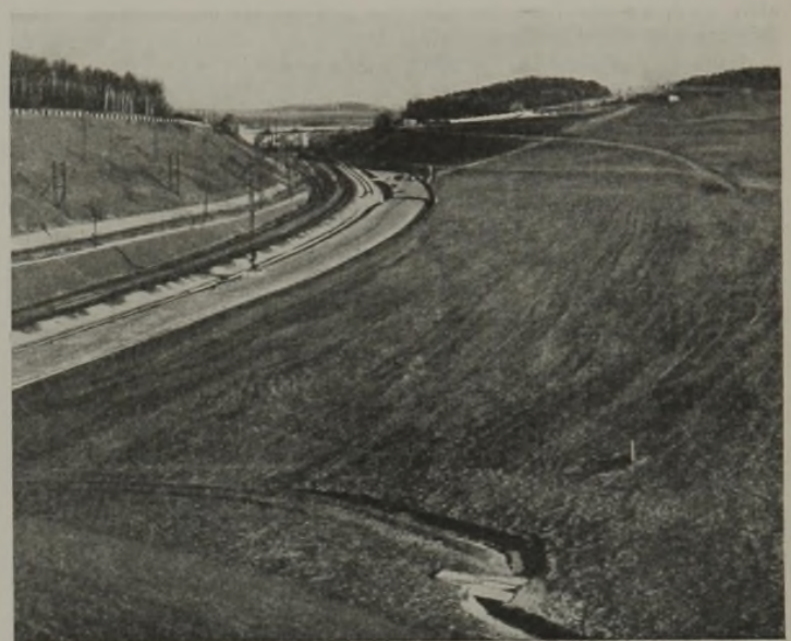
Abb. 9. Fertigstellung der Bauarbeiten. Blick von der Lichtenberger Brücke nach Osten auf das Gebiet der früheren Rutschungen und, im Vordergrunde, der vom Dezember 1925. Im Hintergrunde rechts Übergang der Böschung 1:5 auf 1:1,5. Am Fuße der Abflachung die Planumverbreiterung mit den befestigten Gräben an beiden Seiten. Ganz vorn gepflasterte Rinne am Fuße des Böschungskegels der Brücke. Ganz links das Umfahrungsgleis oberhalb der Streckengleise mit Böschungsfußbefestigung.
