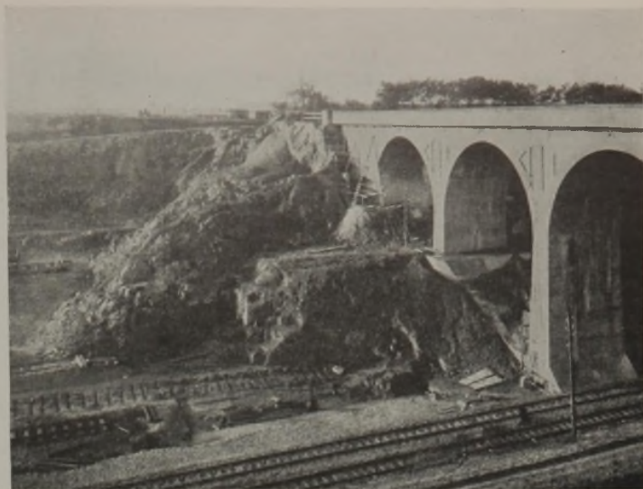
Abb. 3. Erdarbeiten an der hohen Lichtenberger Brücke. Am Fuß der Brücke stehen die Tone noch fast senkrecht, links davon abrutschende Tone, ganz links Beginn des Abflachens.
