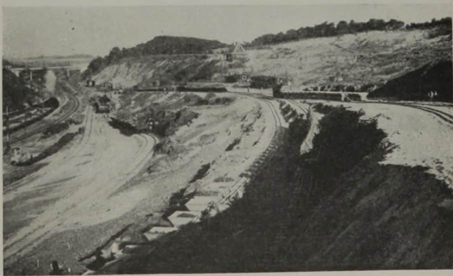
Abb. 5. Beginn der Abflachungsarbeiten auf 1:5 mit Blick nach Osten auf den Bahnhof Rosengarten. Im Vordergrund fast senkrecht stehende Tone.
