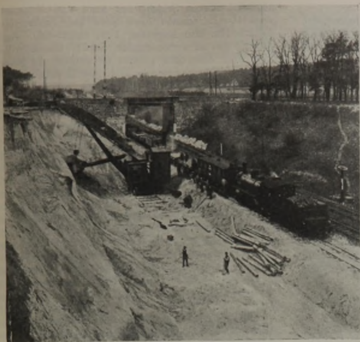
Abb. 2. Die Tone sind beim Beginn der Bauarbeiten im Jahre 1910 so fest, daß sie fast senkrecht stehen.
