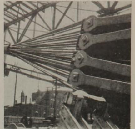
Abb. 3 zeigt am amerikanischen Widerlager die von der Kabelschelle strahlenförmig zu den Strangschuhen führenden Stränge.
