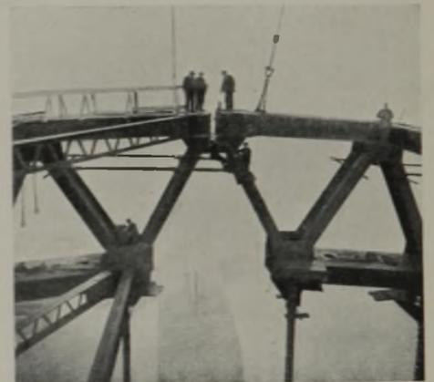
Abb. 4. Einbau des behelfsmäßigen Mittelgelenks beim Zusammenschluß der Obergurte in Brückenmitte.
