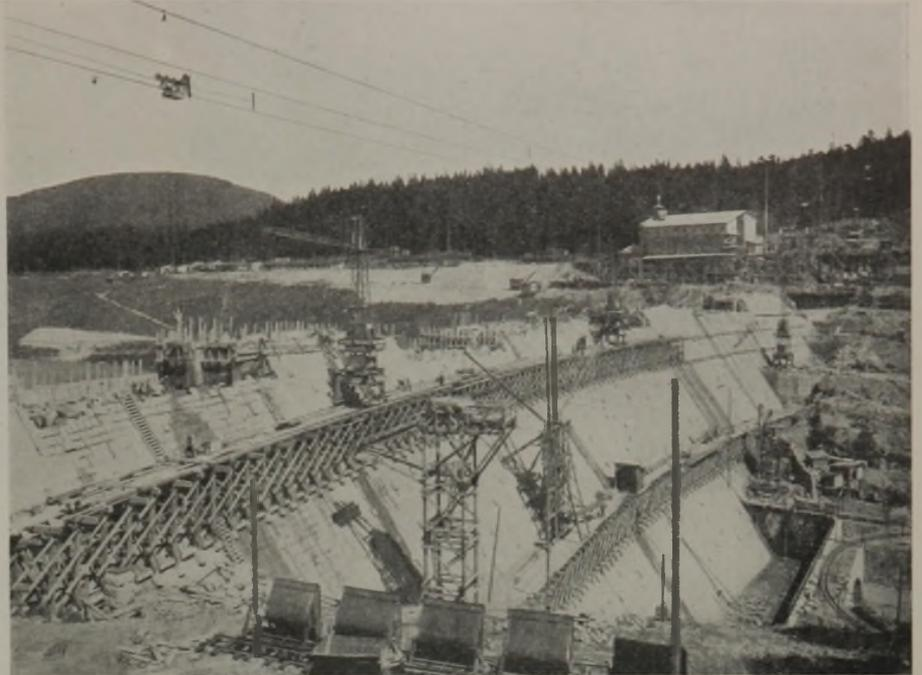
Abb. 7. Betonieren einer Talsperre. (Kabelkrananlage beim Bau der Schwarzenbachtalsperre.)
