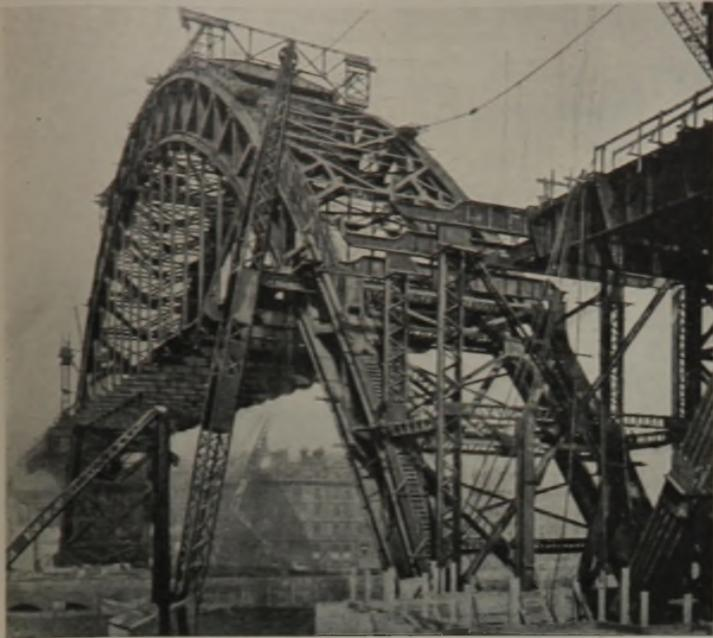
Abb. 1. Fertig montierte Bogen vor Herstellung der Turmpfeiler.
