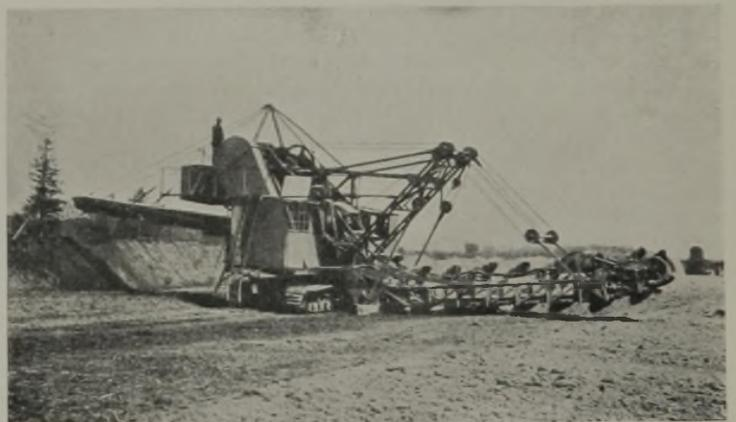
Abb. 5. Abdeckung von Mutterboden durch Eimerkettenraupenbagger.
