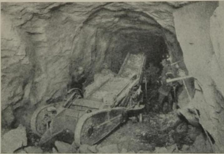
Abb. 8. Verlademaschine im Stollen (Schauffellader).
