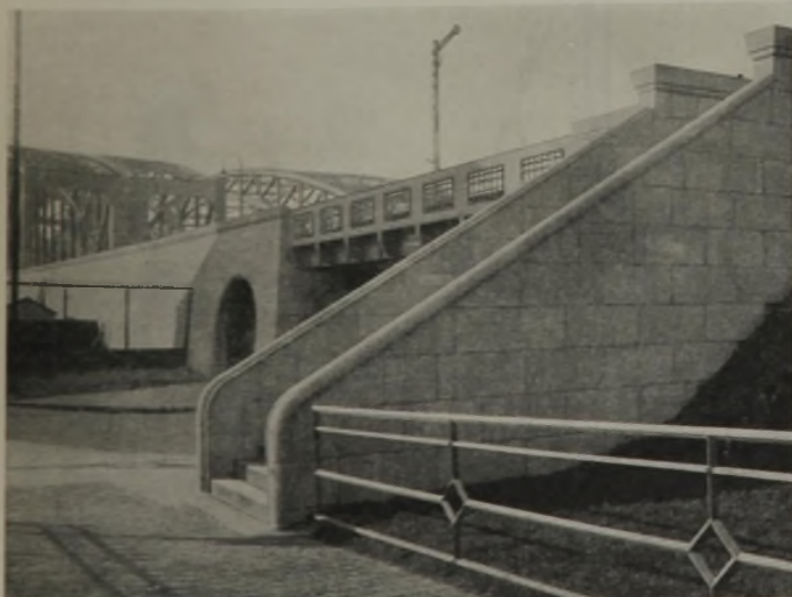
Abb. 30. Aufgang zum öffentlichen Fußweg der neuen Norderelbebrücke.
