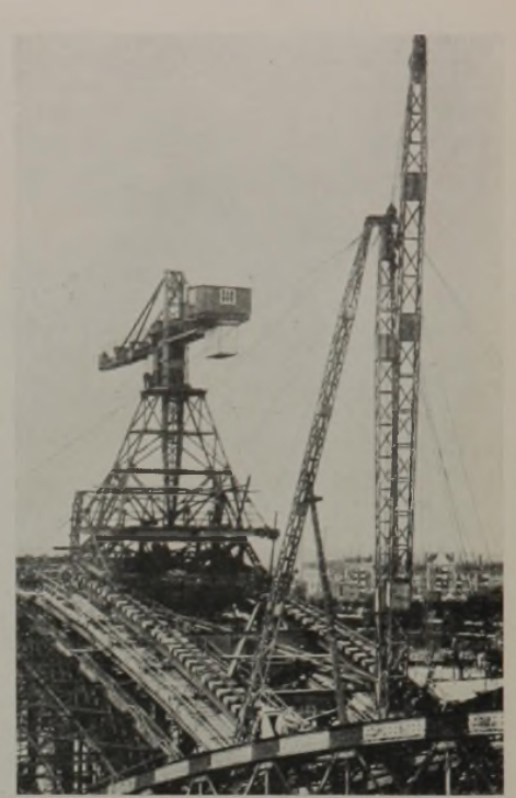
Abb. 19. Schwenkmast und Kranbahn auf der neuen Gurtung mit darauf befindlichem Vorbaukran.
