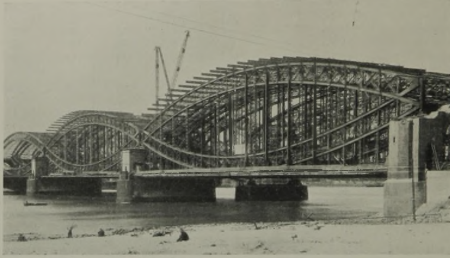
Abb. 14. Alte Brücke. Die Peiner Träger sind auf zwei Überbauten bereits aufgebracht.
