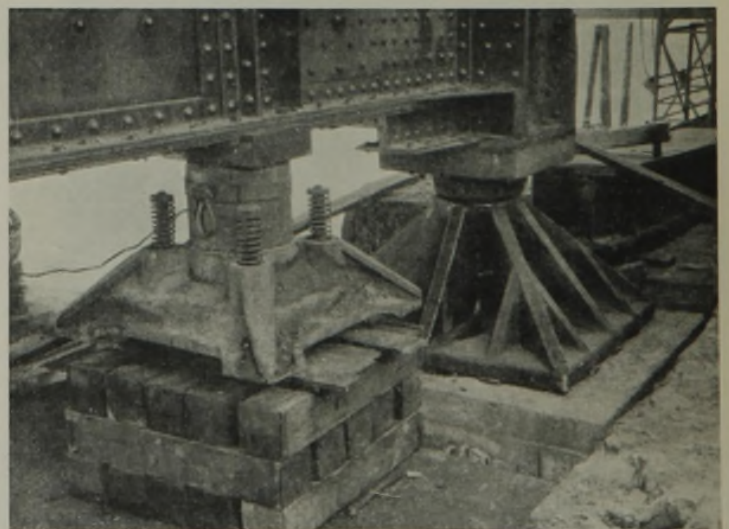
Abb. 25. Ende des Absenkens eines Überbaues.
