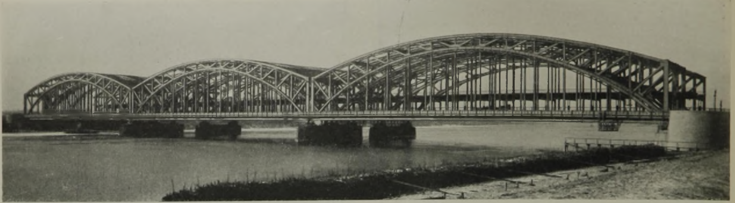
Abb. 32. Die fertige neue Norderelbebrücke.
