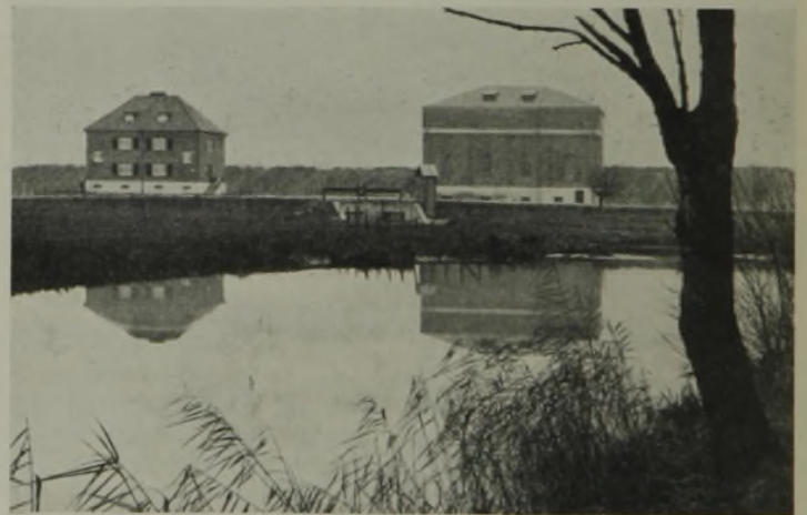
Abb. 12. Pumpwerk Repelen mit Wärterhaus; im Vordergrund das Auslaufbauwerk mit selbstschreibendem Pegel und Meßwehranlage.
