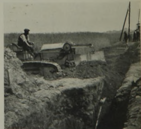
Abb. 3. Zuschütten eines Grabens mittels Raupenschleppers.
