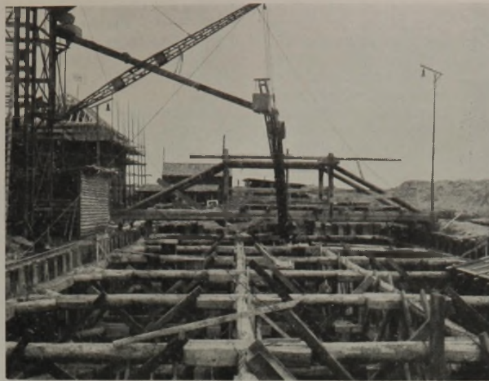
Abb. 8. Aussteifung der Baugrube und Gießturmanlage.
