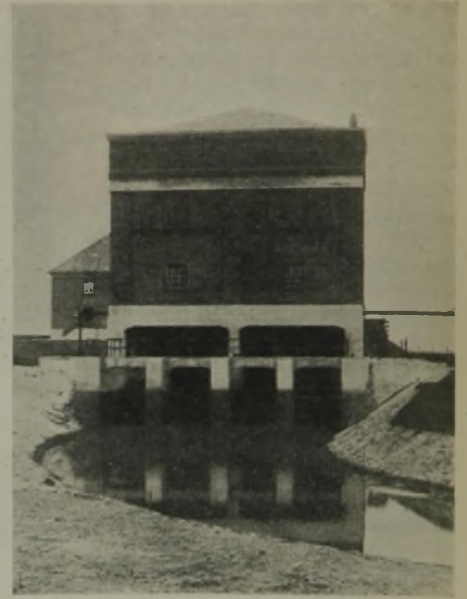
Abb. 13. Blick auf das Einlaufbauwerk mit Rechenanlage.
