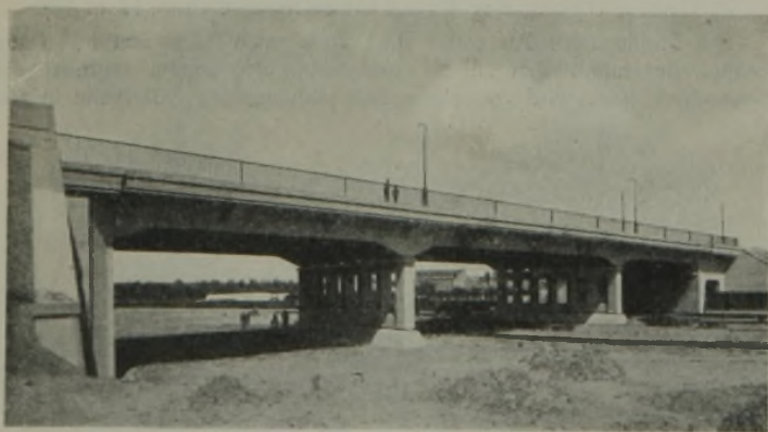
Abb. 15. Überführung der Kreckower Straße.
