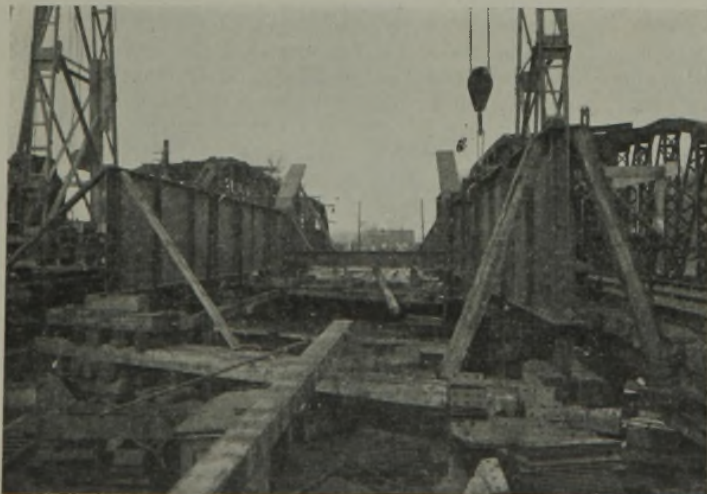
Abb. 19. Montage der Hauptträger. Beginn des Einbaues der Fahrbahn.
