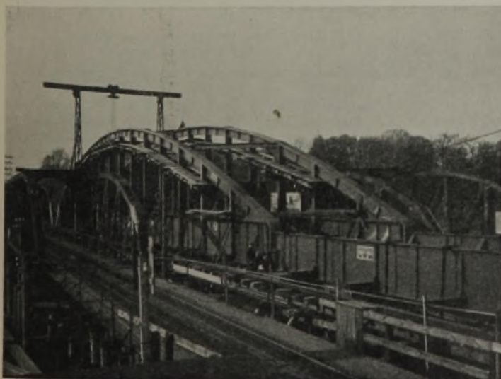
Abb. 23. Fast vollendete Montage der Brücke für Gleis Magdeburg—Berlin.
