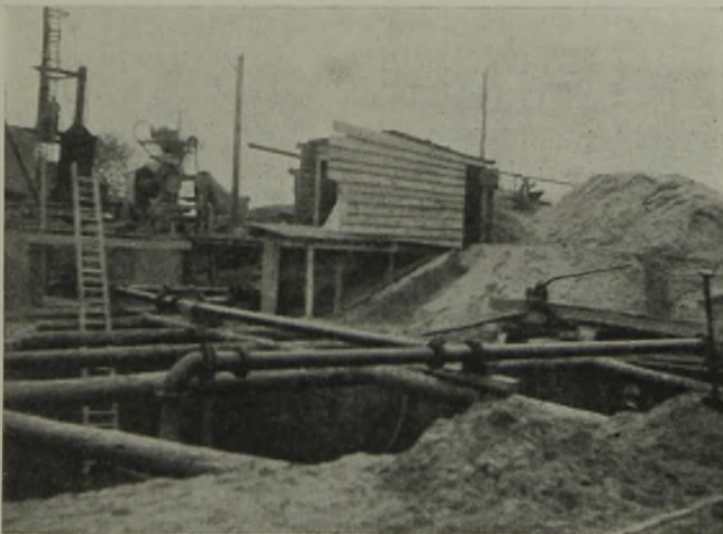
Abb. 8. Maschinenhausbaugrube mit Grundwassersenkungsanlage.
