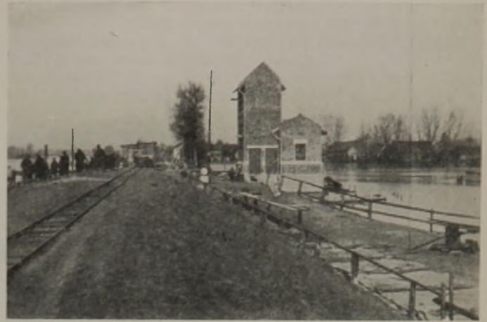
Abb. 13. Beginn mit dem Abpumpen des Binnenwassers.
