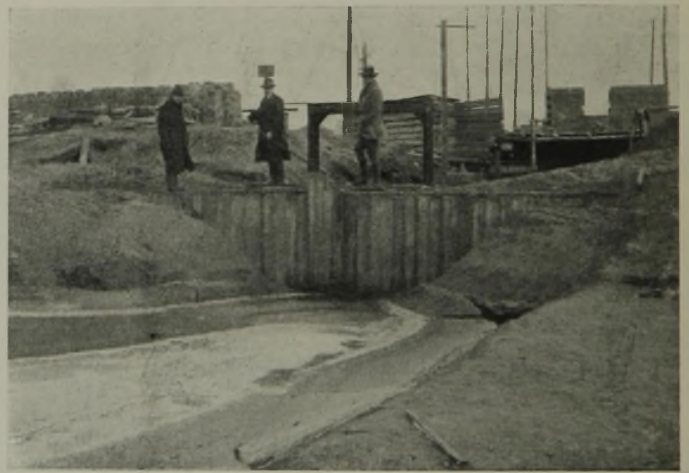
Abb. 10. Blick auf die Querspundwand am Auslaufbauwerk bei steigendem Außenwasser.
