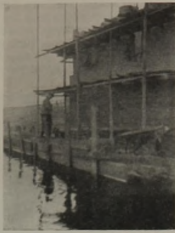
Abb. 12. Anlage des Schutzwalles auf der Binnenseite.
