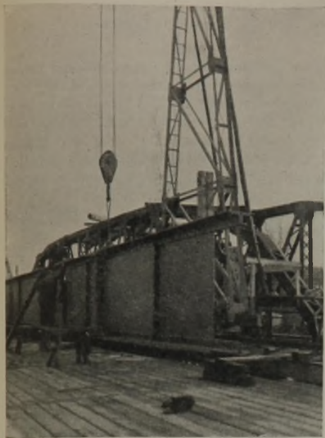
Abb. 21. Freivorbau über der Hauptschiffahrtöffnung.
