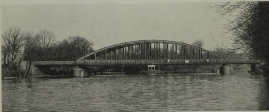
Abb. 25. Das fertige Bauwerk.
