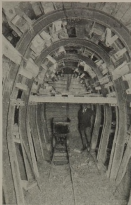
Abb. 6. Stollenvortrieb unter den Eisenbahnanlagen (Bauart Kunz D. R. P.).
