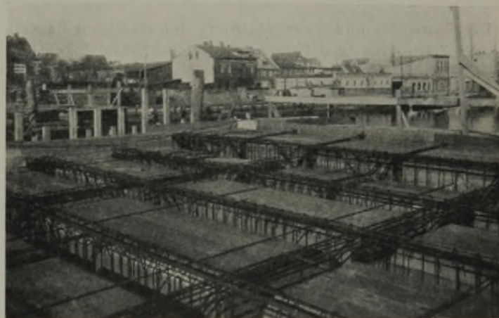
Abb. 5. Eisenflechtwerk einer Seitenöffnung.
