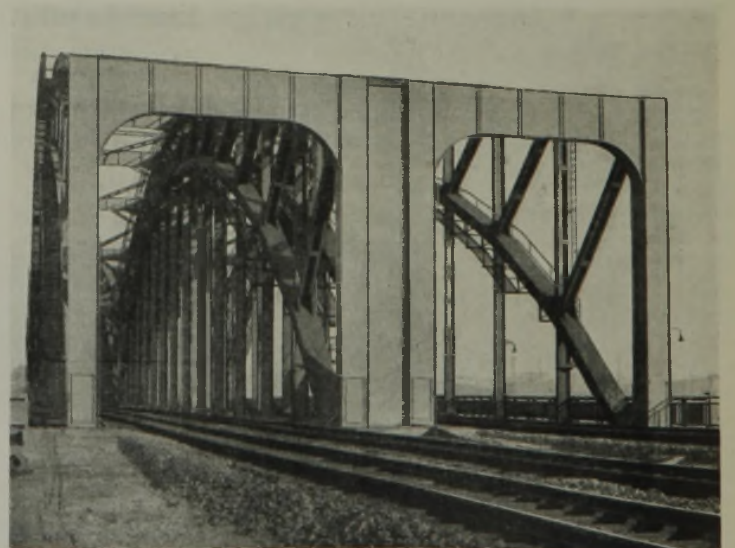
Abb. 6. Endportale nach der Verstärkung.
