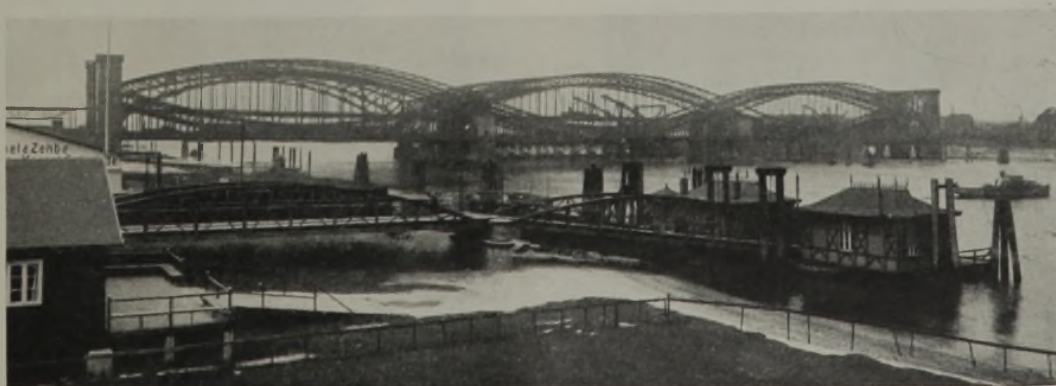
Abb. 2. Alte Brücke, von Südosten gesehen.
