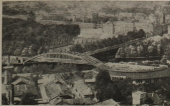
Abb. 3. Erster Neubautwurf (Zweigenkbogen l = 85 m).
