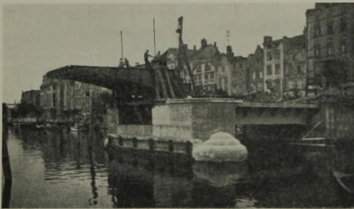
Abb. 11. Absenken der vorgeschobenen Klappe.
