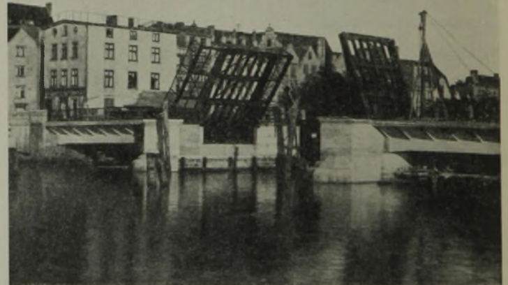
Abb. 12. Eisengerippe der Klappe in geöffnetem Zustande.
