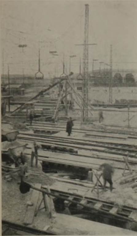
Abb. 4. Offene Kanal-Baugrube unter den in Betrieb befindlichen Eisenbahnanlagen.
