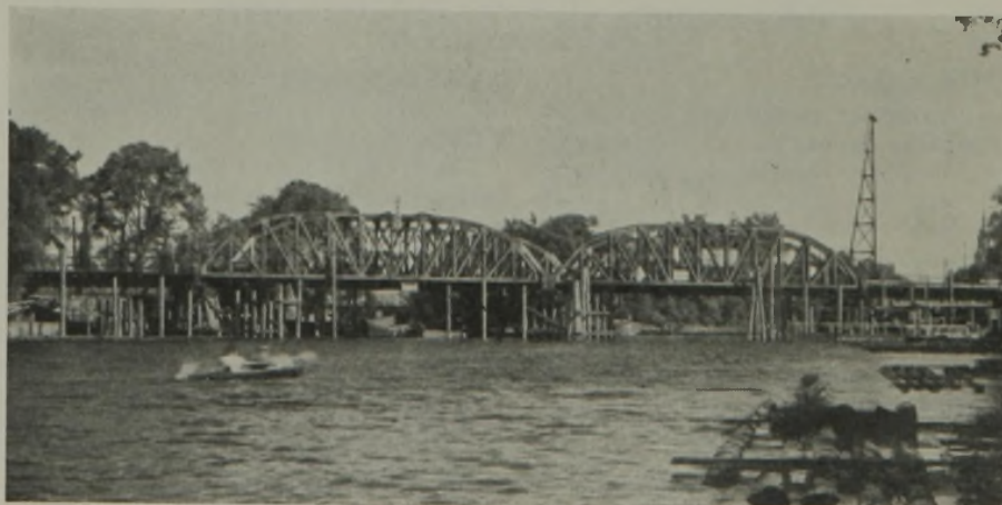
Abb. 13. Ansicht der Hilfsbrücke von Süden.
