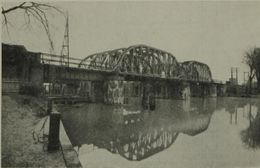
Abb. 1. Die alte Havelbrücke (bis zum Jahre 1926). Schwedlerträger.
