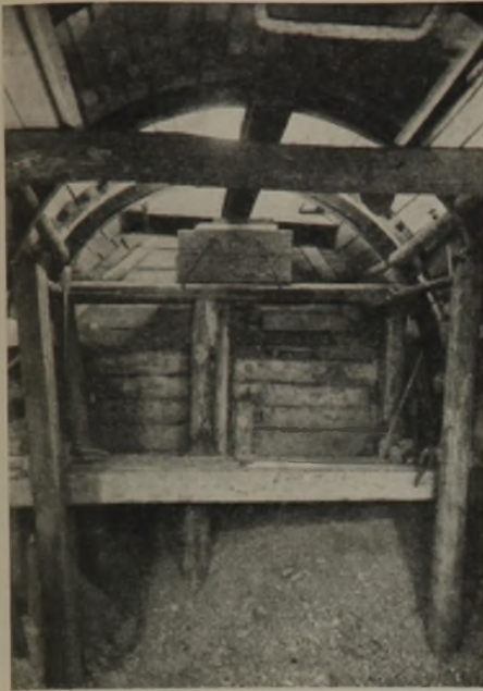
Abb. 9. Kanal Eisenheimer Straße: Tunnelvortrieb und Brustverschalung.
