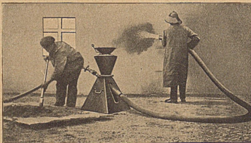
Mörtelspritzmaschine — Bauart Moser-Kraftbau — in Tätigkeit.
