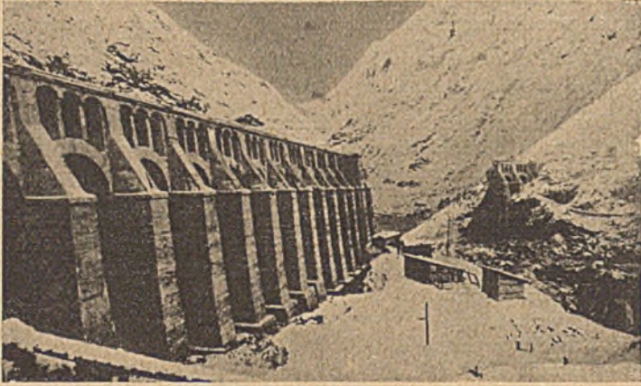
Abb. 1. Ansicht der Staumauer von der Luftseite.
