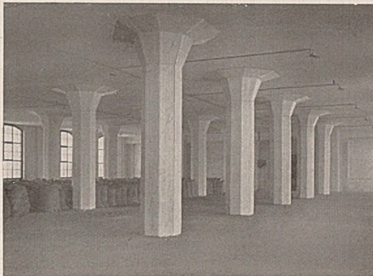
Abb. 12. Speicher in Schottwitz.
