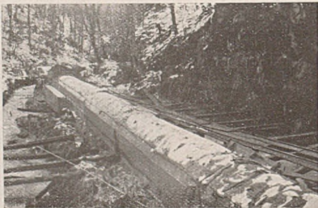
Abb. 8. Betoniertes Rohrstück Seeburg.
