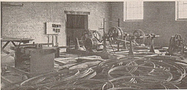
Abb. 4. Eisenbiegemaschine.
