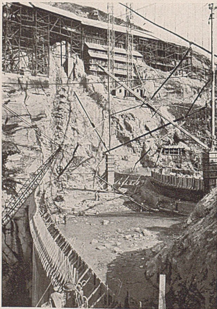
Abb. 1 b. Anwendung des Gußbetons beim Bau der Staumauer Barberine (29. VIII. 23).
