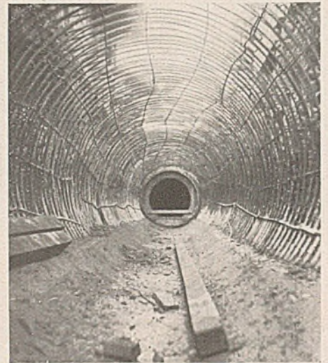
Abb. 14. Blick in die Rohrarmierung Owen.
