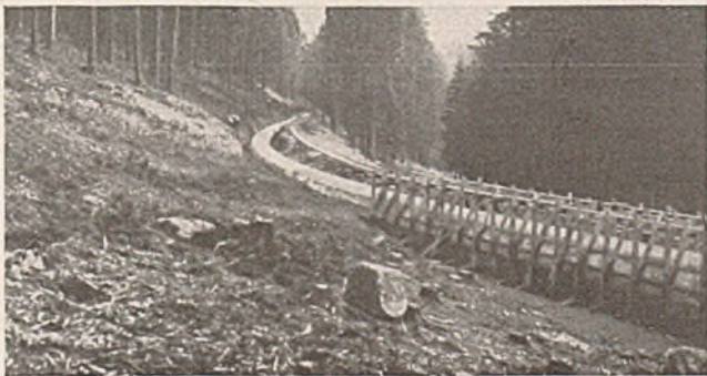
Abb. 17. Fertige Rohrleitung im Gelände.
