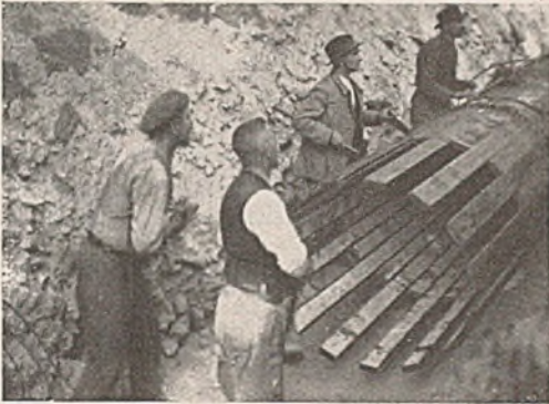
Abb. 16. Vorstrecken der Rohrdauben.
