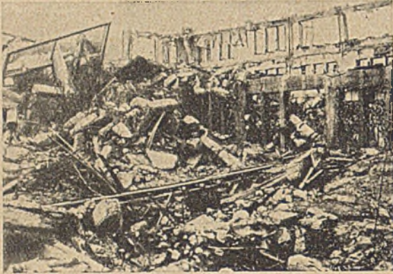
Abb. 13. Zerstörte Eisenbetonbauten in Tokio.
