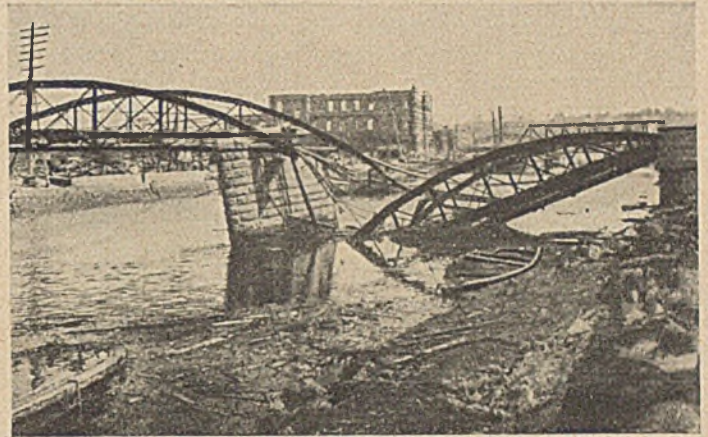
Abb. 24. Kanalbrücke in Yokohama.
