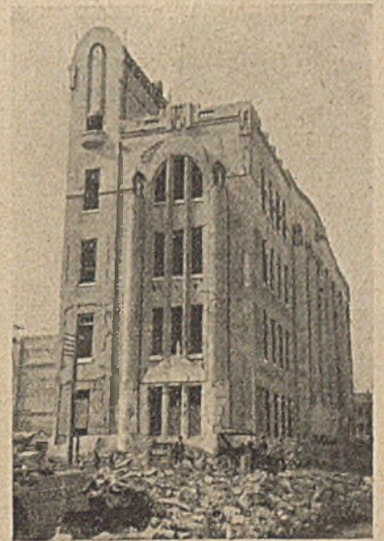
Abb. 12. Haupttelefonamt in Yokohama.
