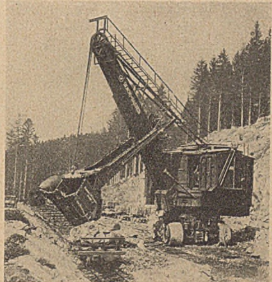
Abb. 2. Löffelbagger 4\text{ m}^3 Inhalt von Menck & Hambrock im Steinbruch.
